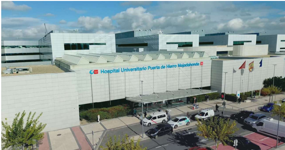
Fig 4.11. Nuevo Hospital Universitario Puerta de Hierro Majadahonda, Madrid (2008).
