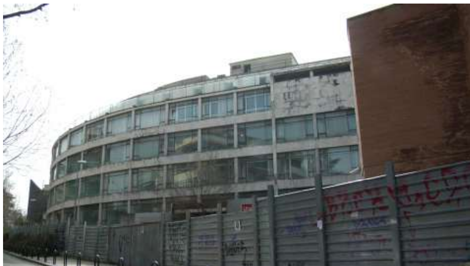
Fig 4.10. Situación de abandono de la Clínica Puerta de Hierro.
