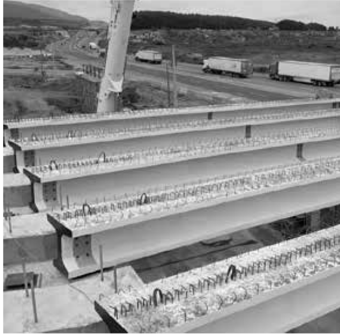
Figura 05. Vigas pretensadas de hormigón. Fuente: Hormisur prefabricado de hormigón
