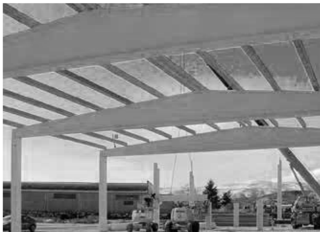
Figura 06. Vigas delta de hormigón prefabricado. Fuente: Tecnyconta
