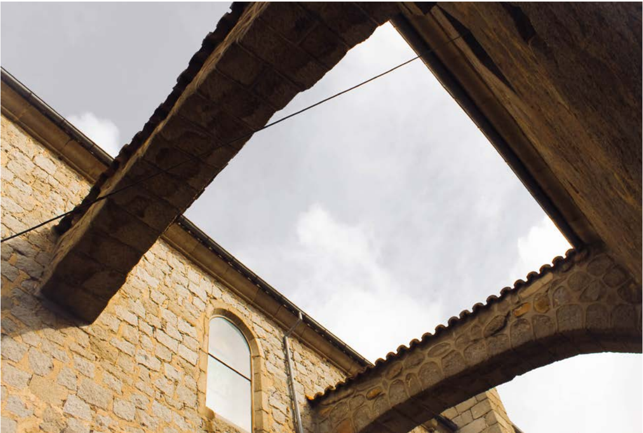
Figura 2.30. Fotografía de los contrafuertes de la nave central de la iglesia. Elaboración propia.
