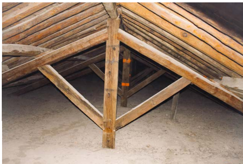
Figura 3.37. Estructura de madera bajo la cubierta del ala oeste. Elaboración propia.
