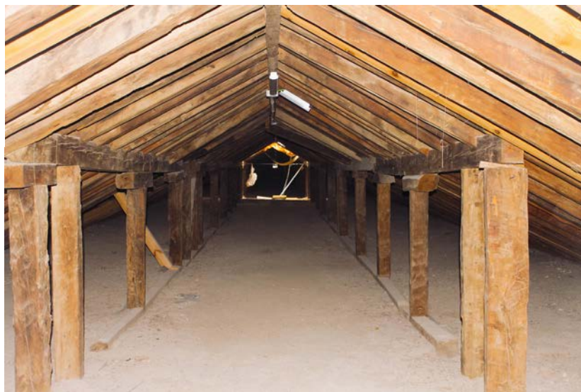
Figura 3.36. Estructura de madera bajo la cubierta del ala sur. Elaboración propia.
