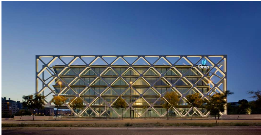
1.3. Edificio Oxseo, Madrid.
