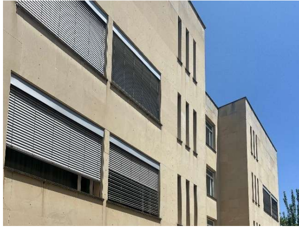
2.3. Fachada sur del Pabellón Nuevo de la ETSAM.
