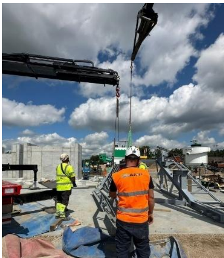
FIGURA 38: MONTAJE DE LAS ESTRUCTURAS MEDIANTE GRÚAS
