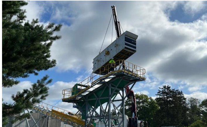
FIGURA 39: MONTAJE DE LA CRIBA EN LA ESTRUCTURA
