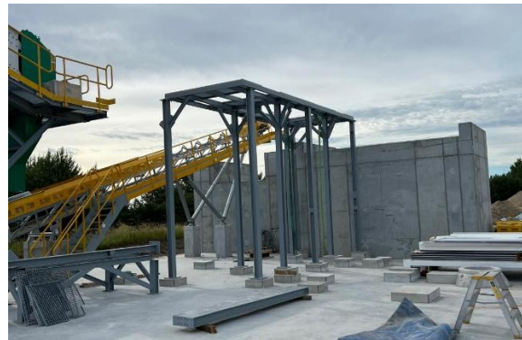
FIGURA 36: MUROS DE SEPARACIÓN PARA LOS ACOPIOS
