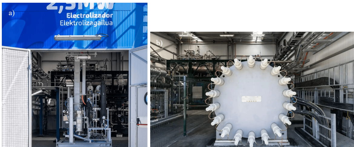
Figura 10: Imágenes reales del electrolizador de 2.5 MW de Petronor en el parque tecnológico de Abanto, Bilbao. Fuente: Imagen departamento de transformación industrial de Repsol.
