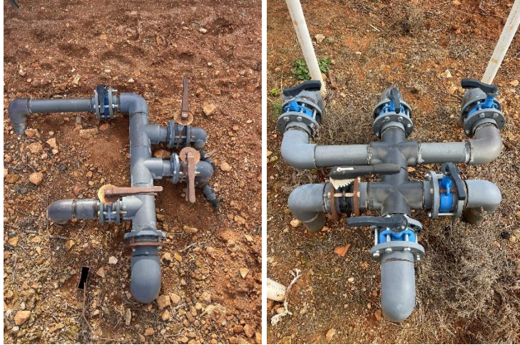
Figura 8 Arquetas ya existentes.
