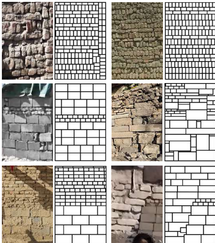
(Fig 6.10) Dibujos realizados por el autor, análisis de configuración de mamposterías y muros de fábrica
