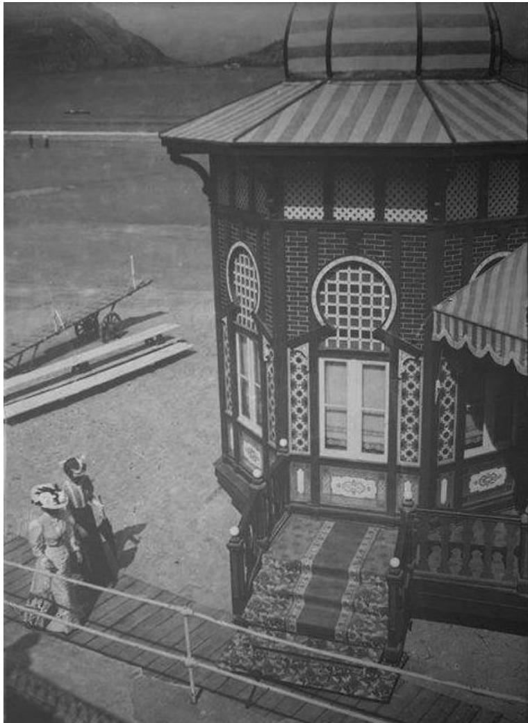
FIGURA 29_ Fotografía. Caseta Real de Baños (1894). Detalle de fachada y puerta de acceso.
