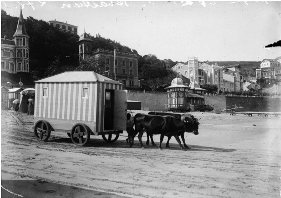
FIGURA 20_Fotografía. Caseta de baños desplazada mediante bueyes en la playa de La Concha, San Sebastián. Al fondo la Caseta Real de Baños de María Cristina (1894).
