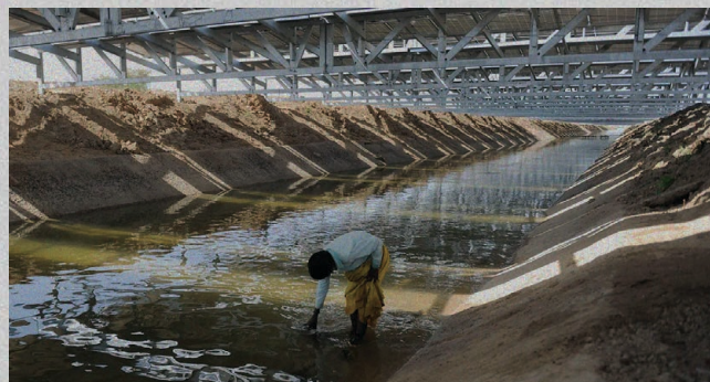
Los canales solares están suspendidos sobre una estructura metálica elevada sobre el canal, lo que aporta beneficios tanto para la conservación del agua —al reducir la evaporación— como para la refrigeración de los paneles solares, que mejora su eficiencia. [Fig. 118]
