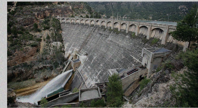
Presa de la Fuensanta en el río Segura. [Fig. 249]
