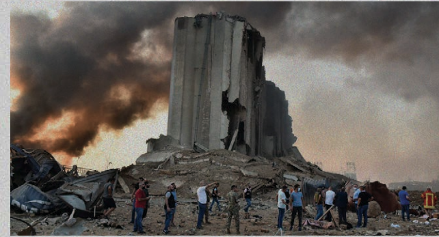
Vista de los silos de grano destruidos tras la explosión causada por el almacenamiento negligente de nitrato de amonio. Puerto de Beirut, 2020. [Fig. 232]
