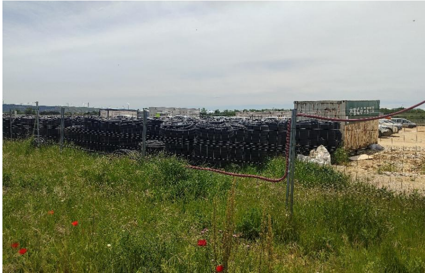
Figura 18- Cableado a instalar, Grijota IV (Elaboración propia).
