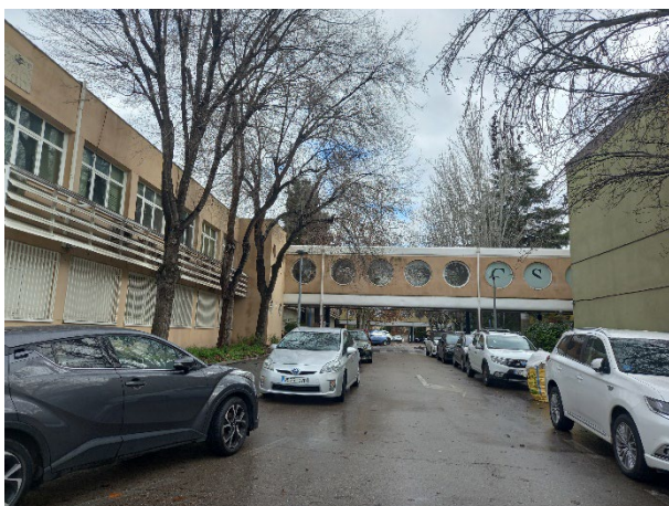
Ilustración 6. Imagen de corredor del edificio de la ETSIST, ETSISI y CSDMM. Fuente: Elaboración propia
