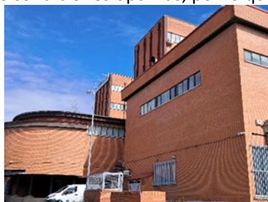
Ilustración 23. Fachada. Fuente: Elaboración propia
