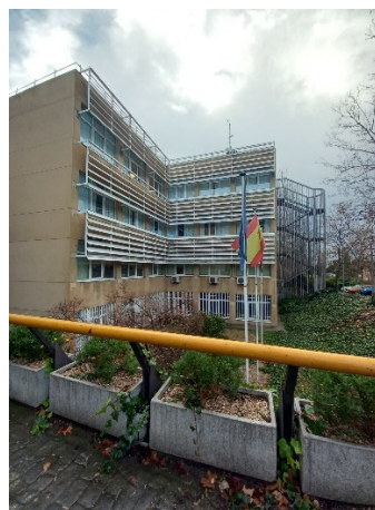
Ilustración 7. Parasoles exteriores del edificio de la ETSIST, ETSISI y CSDMM. Fuente: Elaboración propia
