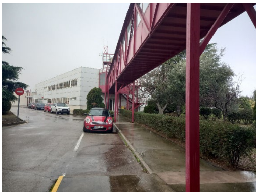
Ilustración 68. Pasarela exterior y edificio docente del INSIA. Fuente: Elaboración propia
