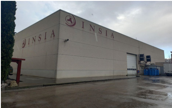
Ilustración 66. Imagen general de la nave del INSIA. Fuente: Elaboración propia
