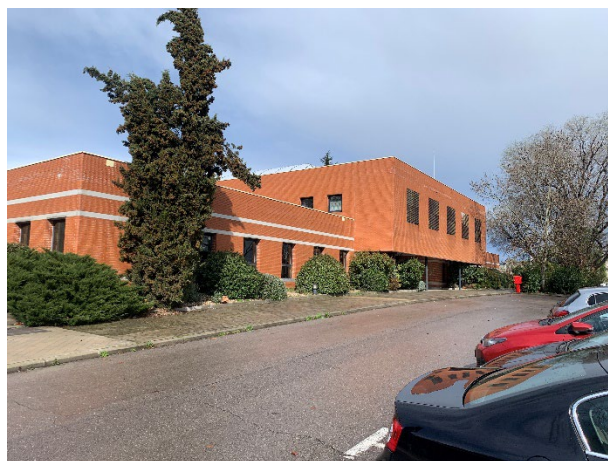
Ilustración 55. Acceso por fachada sur del edificio Arboleda
