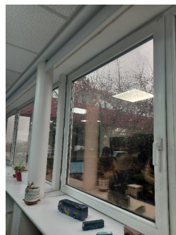
Ilustración 71. Ventana interior de las oficinas en la nave del INSIA. Fuente: Elaboración propia
