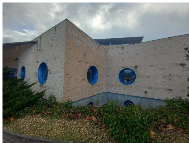
Ilustración 9. Edificio de Servicios Comunes (cafetería). Fuente: Elaboración propia
