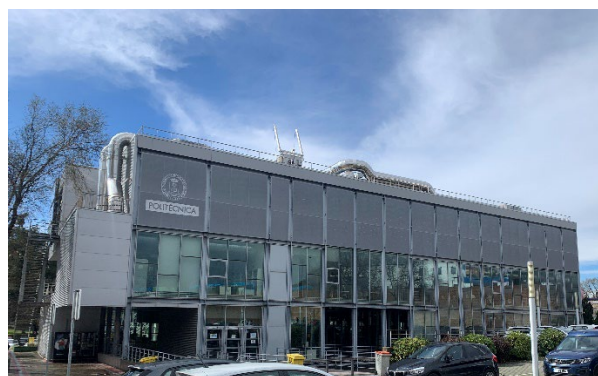
Ilustración 50. Vista de la fachada este de la biblioteca
