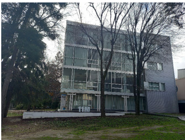
Ilustración 8. Edificio nuevo anexo (Informática). Fuente: Elaboración propia
