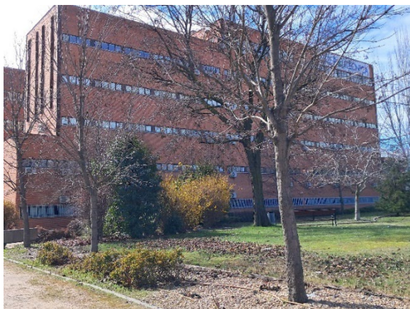
Ilustración 14. Fachada norte del edificio de la ETSIGCT. Fuente: Elaboración propia
