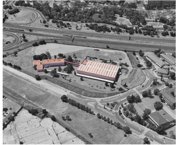
Ilustración 57. Imagen general del edificio del INSIA. Fuente: Google maps
