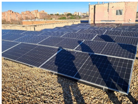
Ilustración 15. Cubierta bloque aulas del edificio de la ETSIGCT. Fuente: Elaboración propia
