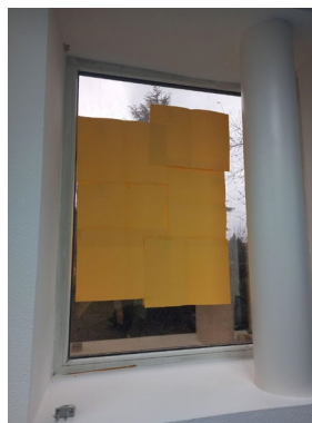
Ilustración 72. Ventana interior de las oficinas en la nave del INSIA. Fuente: Elaboración propia
