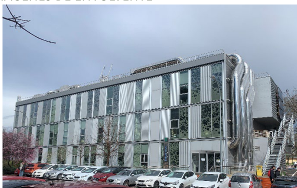
Ilustración 49. Acceso principal a la biblioteca por fachada oeste
