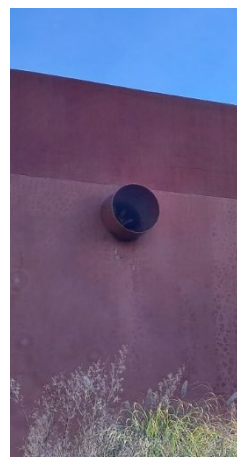
Ilustración 36. Salida de conducto a fachada del edificio Polideportivo. Fuente: elaboración propia
