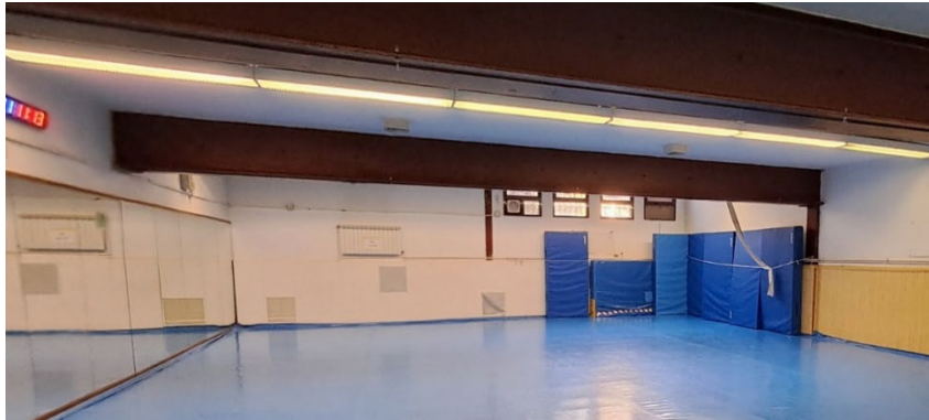
Ilustración 45. Cámara en paramento del fondo en la Sala de gimnasia. Ventanas altas que no se abren regularmente. Polideportivo. Fuente: Elaboración propia
