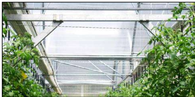
FIGURA 4. REFUERZOS EN FORMA DE K. FUENTE: WWW.ULMAAGRICOLA.COM
