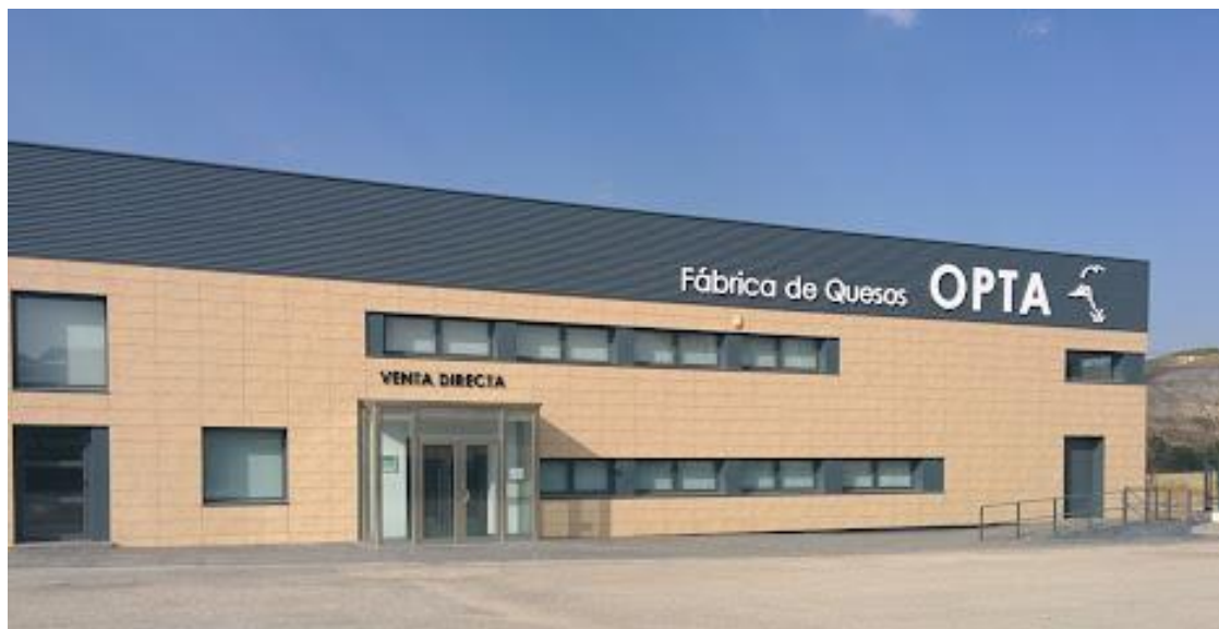
Figura 3. Vista a pie de carretera de la fábrica Lacto Ganadera Río Mayor S.L. (Google Maps, 2024).
