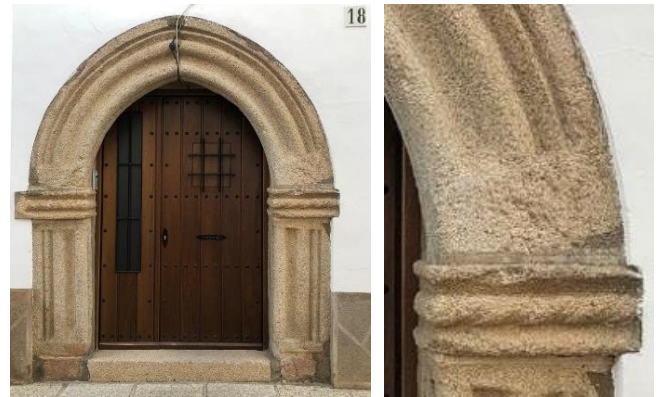
[20] Cortizada, 18 y detalle del arranque del arco
