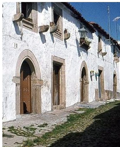
[08] ventanas, ménsulas y puertas (Antonio Ávila Vega)
