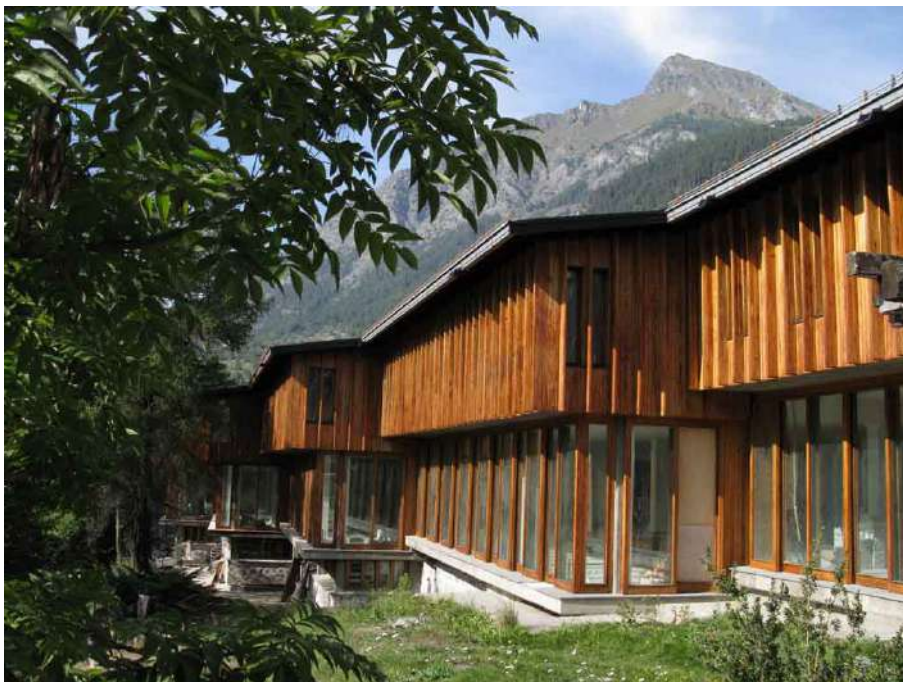
Fig. 146: Detalle del revestimiento de la fachada de la colonia Olivetti en Brusson. Conte y Fiori Arquitectos. Fuente: Politecnico di Torino. https://areeweb.polito.it/ricerca/IAM/?p=992
