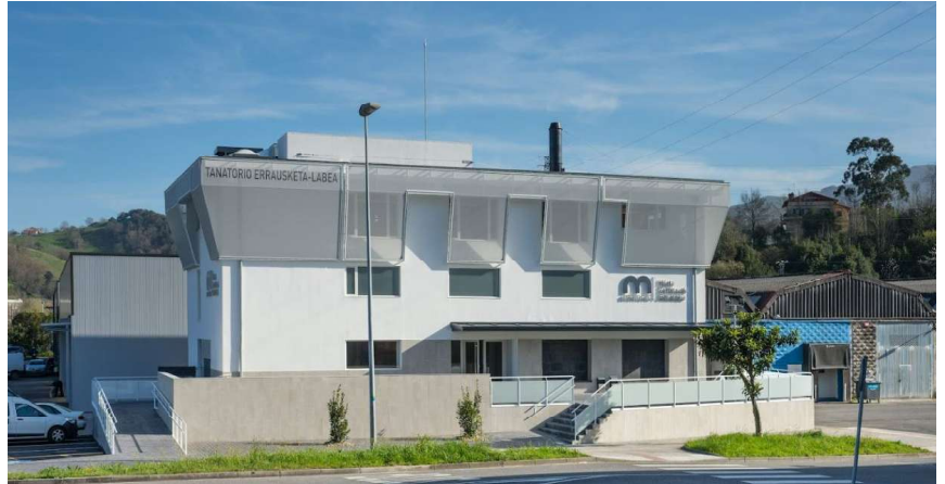
Exterior Fotografía de la Propiedad, Memoria, mar 2020
