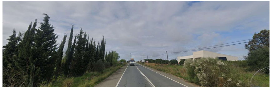
Llegada Google Street View, mar 2024
