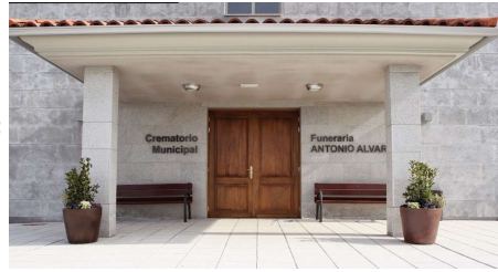
Sala de vela Fotografía de la Propiedad, Crematorio Municipal de Avila Antonio Alvarez, feb 2010
