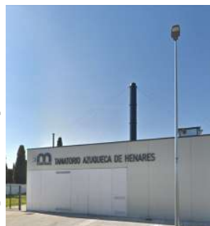
Aparcamiento Google Street View, sept 2018
