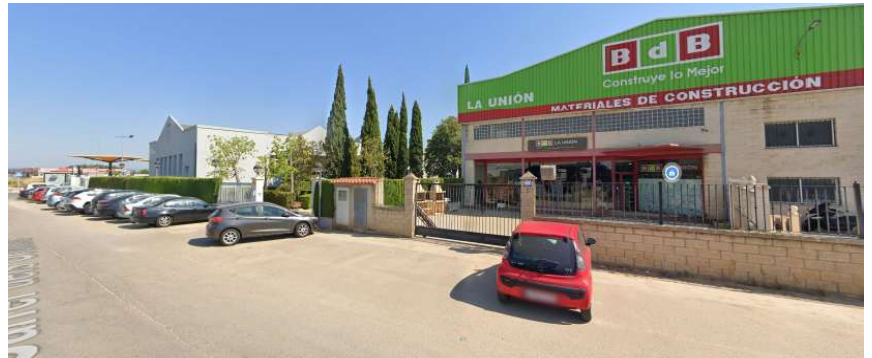
Exterior Nótese - Detalle templete a dos aguas, jardín y naves. Google Street View, jul 2022
