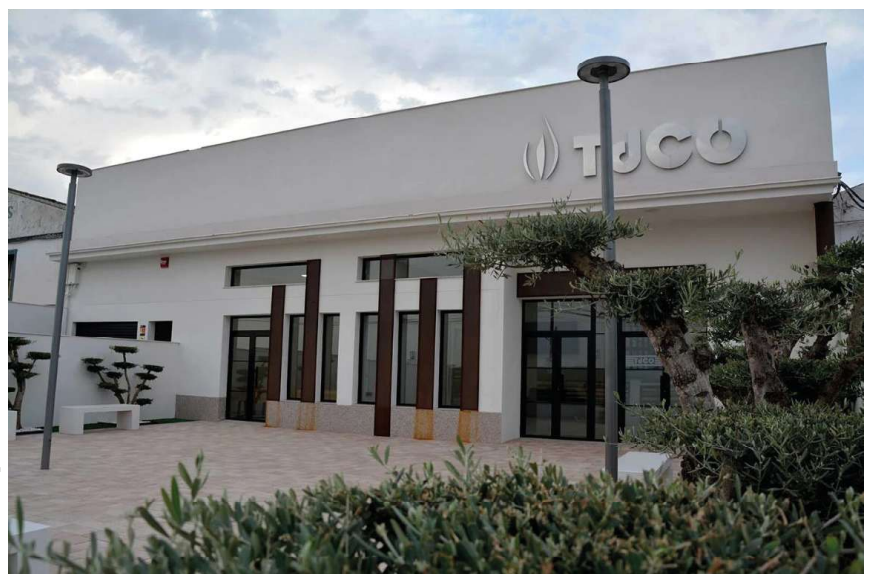
Fachada Fotografía de la Propiedad, Reconstrucción Empresa TdCO.
