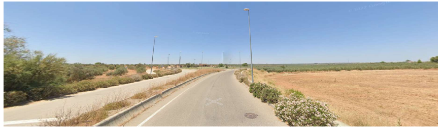
Llegada en construcción Google Street View, Jul 2022
