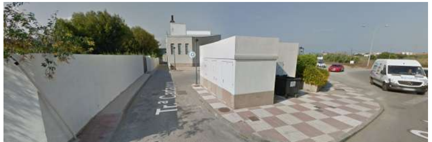
Entorno Nótese - Chimenea Google Street View, sept. 2017
