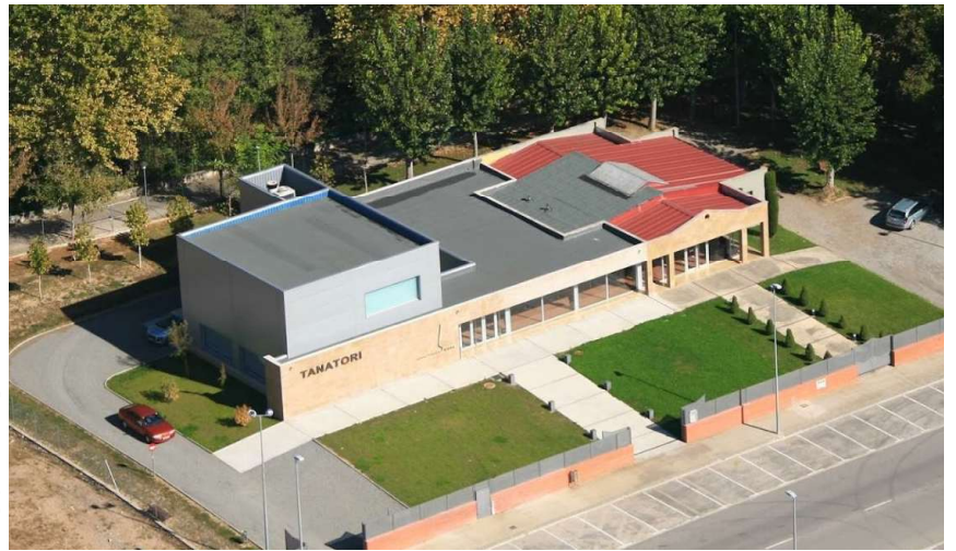
Entorno Nótese: Chimenea escondida. Fotografía de la Propiedad, Servis Finmeraris Xinyo, ene. 2014
