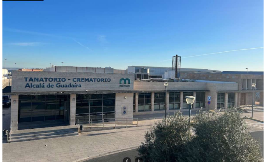
Fachada - Chimenea Usuario de Google, Antonio Ortiz
