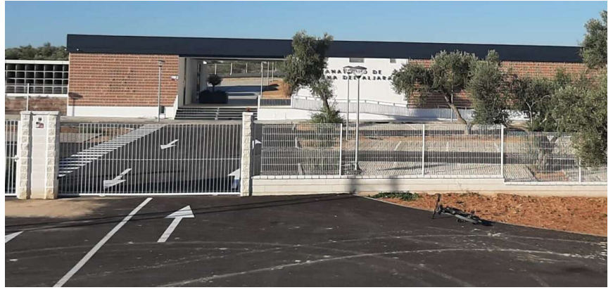
Fachada-entrada Fotografía de la Propiedad, Tanatorio de Mairena del Aljarafe.
