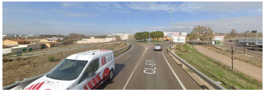
Llegada Google Street View, mar 2022
