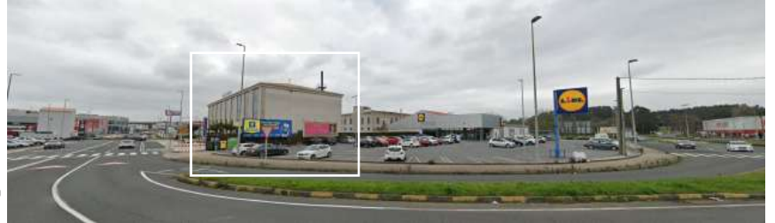
Llegada Google Street View, mar. 2022
