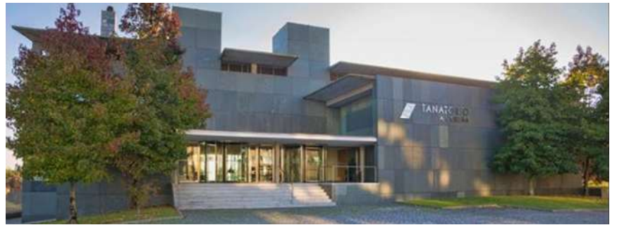
Entorno - Fachada principal Fotografía de la Propiedad, Serrisa, feb. 2016
