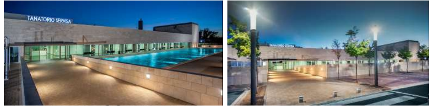
Entorno Fotografía de la Propiedad, Servisa, ago 2016
