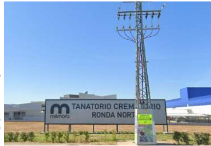
Acceso - Circulación Fotografía de la Propiedad, Memoria.
