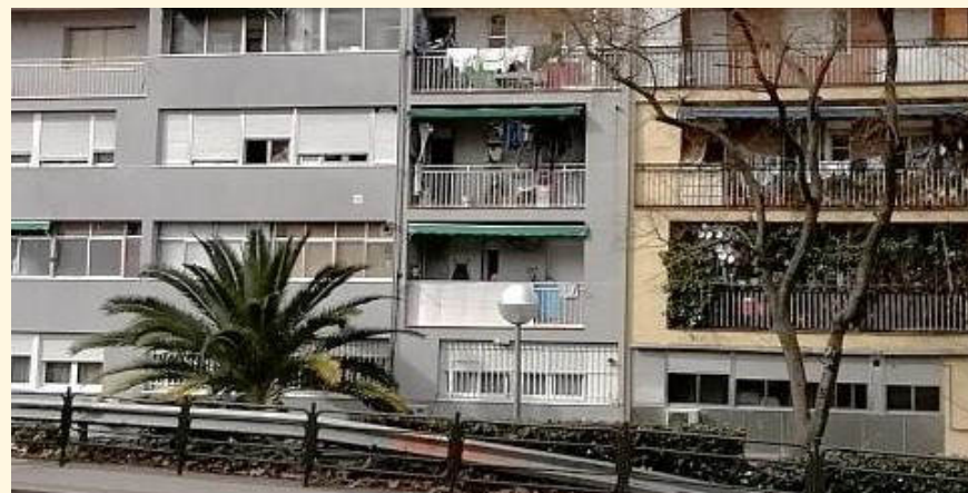
Poblado Dirigido de Fuencarral. Transformación de las fachadas debido a la rehabilitación energética que se está llevando a cabo en algunos bloques.
