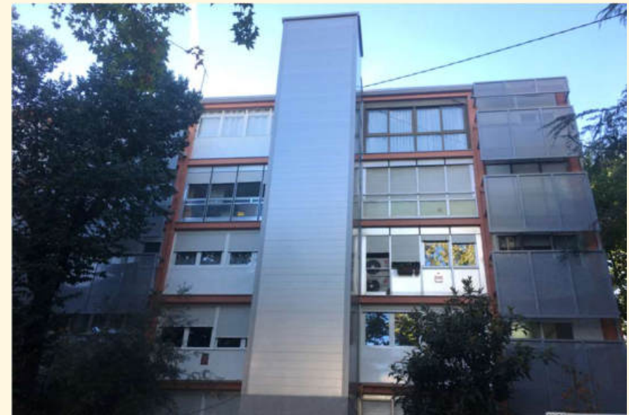
Figura 41. Fotografía de las mejoras a las fachas y adición de ascensor en viviendas colectivas.. Fuente: Fotografías propias.
