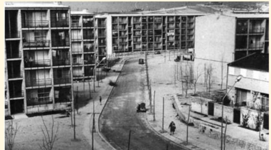
Figura 24. Calles de Fuencarral recién construidas.. Fuente: Architectuul
