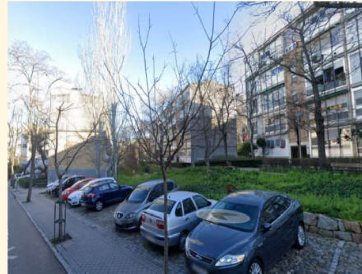
Figura 32 Paisaje edificado del Poblado Dirigido Fuente: Propia
