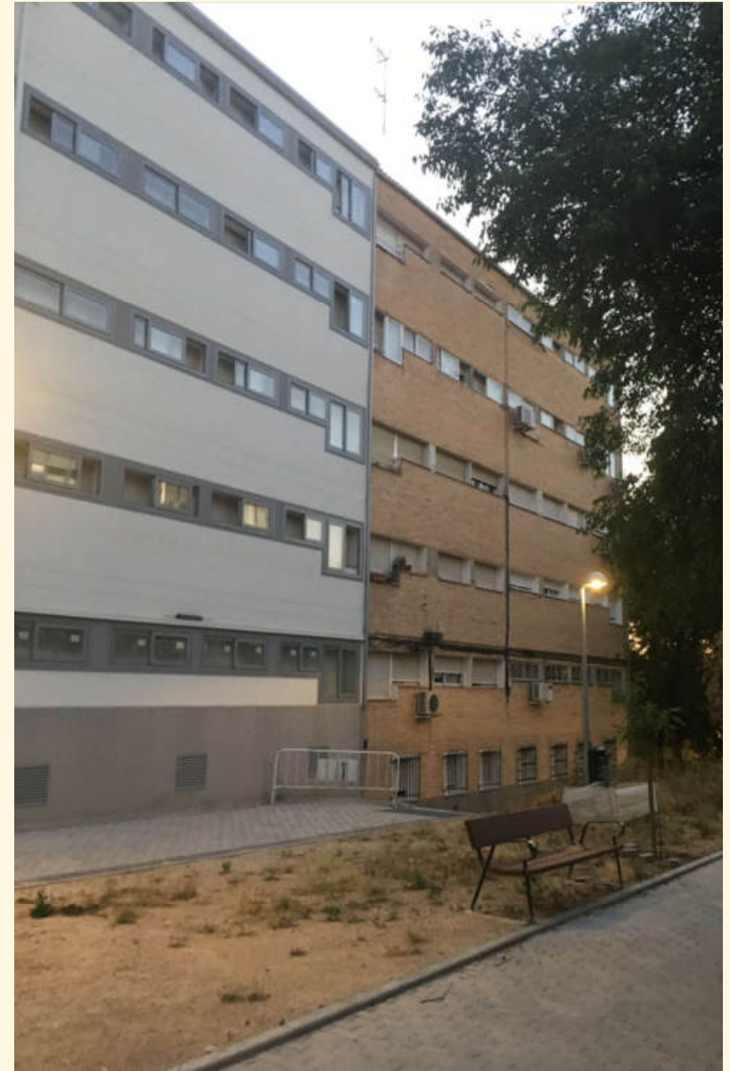
Poblado Dirigido de Fuencarral: Fachada original y fachada remodelada con la rehabilitación energética.
