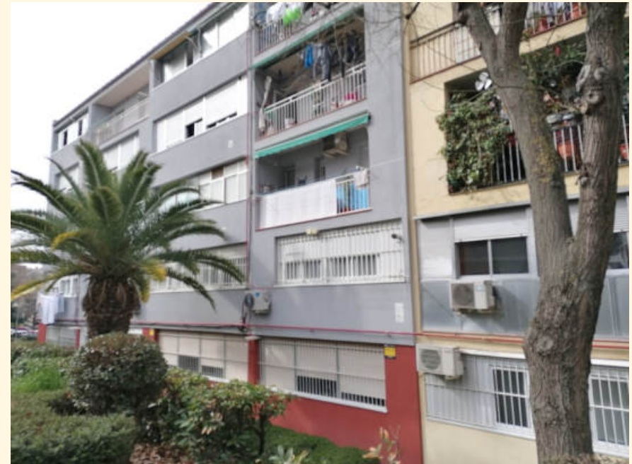
Edificio con rehabilitación energética en el Poblado Dirigido de Fuencarral
