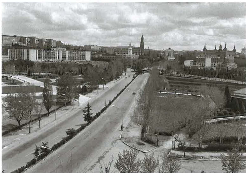
Figura 1.10. Vista de la avenida en los primeros sesenta, a la altura de la Escuela de Agrónomos (1964). A los acentos verticales del monumentalismo de la década anterior (chapiteles del Ministerio del Aire e intercalado del Colegio Mayor José Antonio, torres del Museo de América y de Navales) se superponen nuevas concepciones arquitectónicas de marcada horizontalidad (Escuela de Ingenieros Aeronáuticos, a la izquierda; a la derecha, Casa do Brasil ). (Fuente: Fototeca del Instituto del Patrimonio Cultural de España, Ministerio de Cultura y Deporte, Archivo Pando, signatura: PAN-095250, reproducida con autorización).
