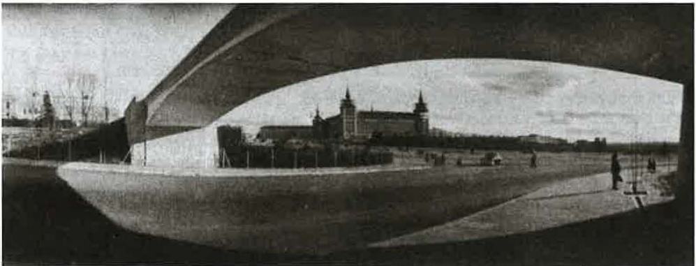
Figura 1.7. Viaducto del tranvía sobre la nueva avenida de los Reyes Católicos. Fuente: Chueca Goitia, Fernando et al. «El Ministerio del Aire», Revista Nacional de Arquitectura , 112 (1951), pág. 29. COAM y Ministerio de Transportes y movilidad sostenible.
