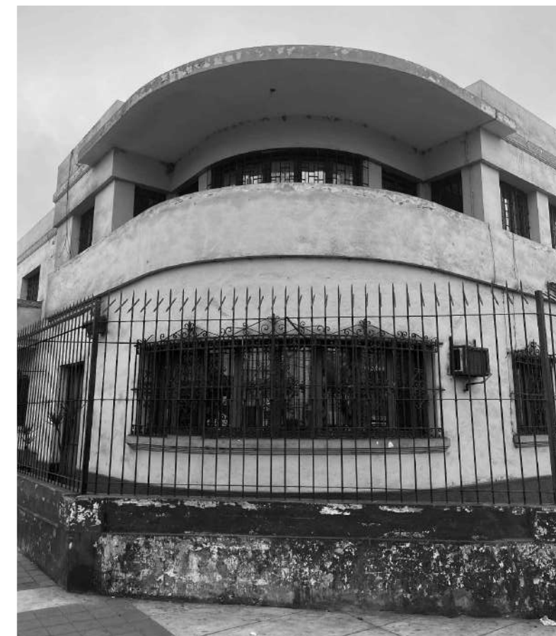
Técnica edificatoria aportada del inmueble Fuente: Archivo personal José Hayakawa
