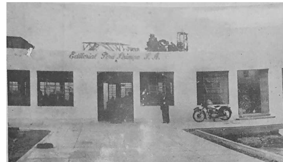
Construcción del primer piso del local de Perú Shimpo con vista desde el patio principal central hacia la fachada principal (1951) Fuente: Perú Shimpo (1951)
