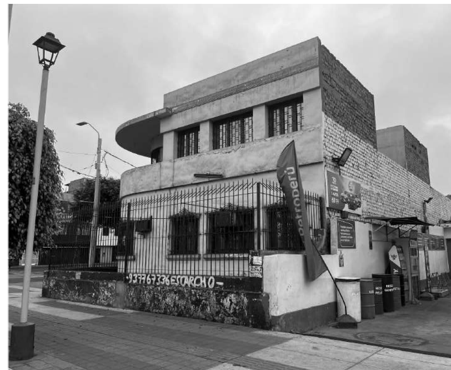
Edificio del diario Perú Shimpo, desde la avenida Sáenz Peña (2025) Fuente: Archivo personal José Hayakawa
