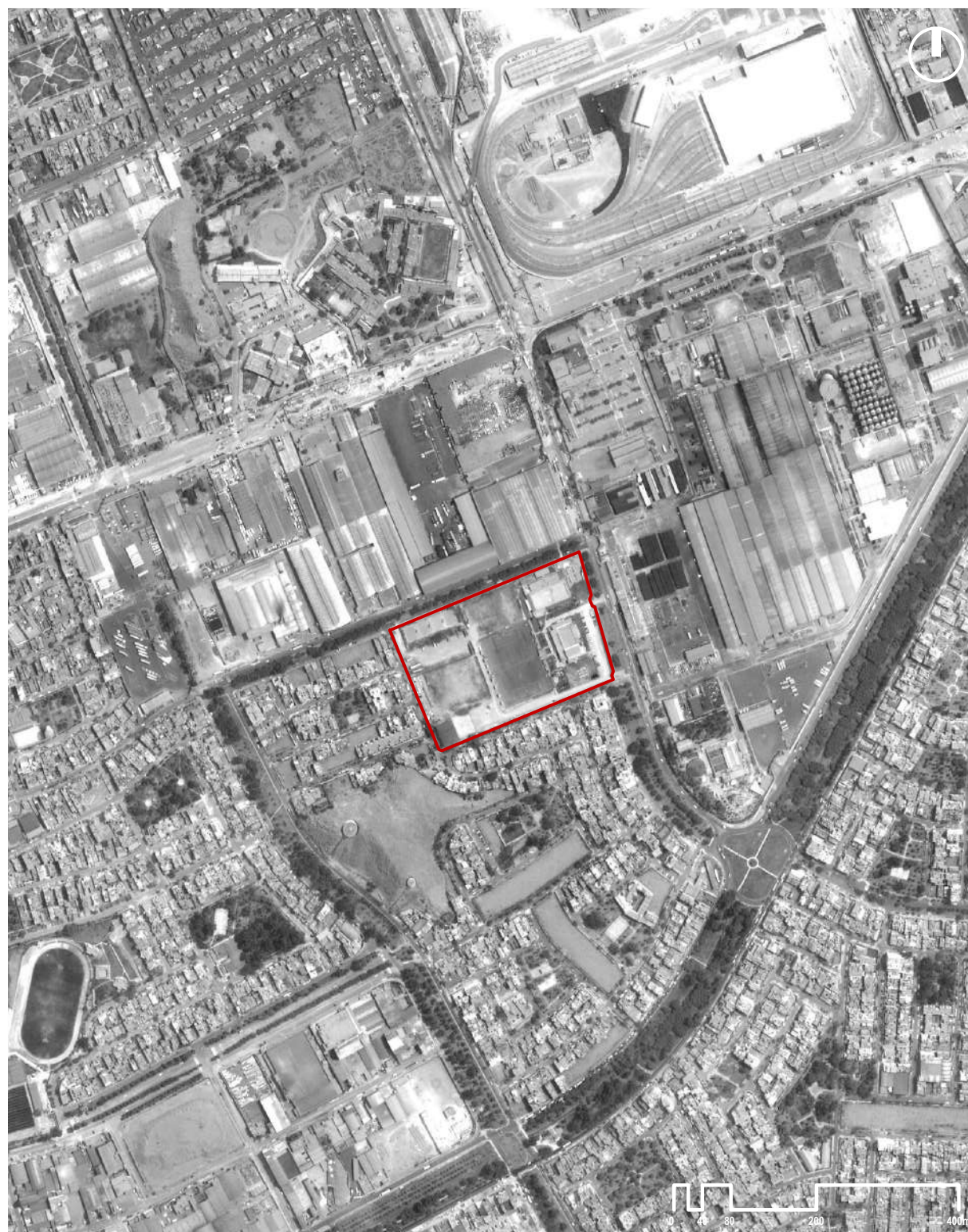
Figura 3: Imagen aérea de abril de 2019 del local de la AOP en Ate, se puede observar el crecimiento de las fábricas cercanas y de los árboles en las áreas verdes. Fuente: Google Earth Pro, (2019)
