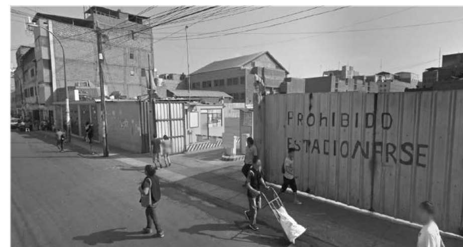
Vista de conjunto del edificio del diario Perú Shimpo, en Barrios Altos (2015) Fuente: Google Earth
