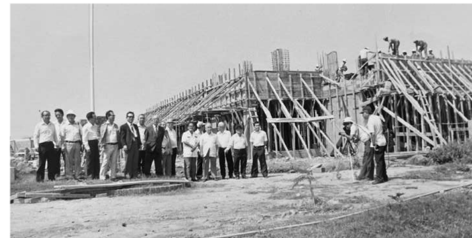
Avance de la construcción del edificio principal (local social), en 1980 Fuente: Archivo institucional AOP
