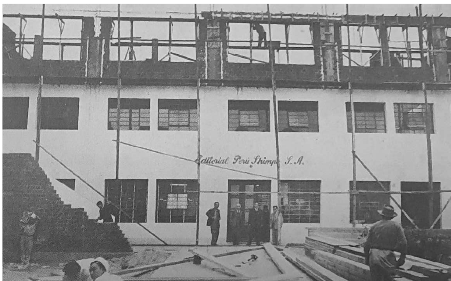
Construcción del auditorio del diario Perú Shimpo (1953) Fuente: Perú Shimpo (1999)
