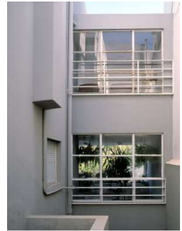
Figura 2.8: Casa Ayala, Miguel Martín-Fernández de la Torre. Fuente: Fundación Docomomo Ibérico
