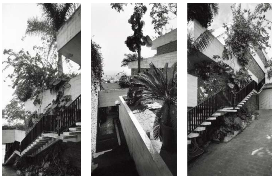
Figura 5.45: Casa Real. Fuente: Fundación Docomomo Ibérico
