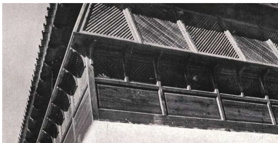
Figura 5.4: Galería de celosía. Fuente: "Revista Nacional de Arquitectura nº140-141"
