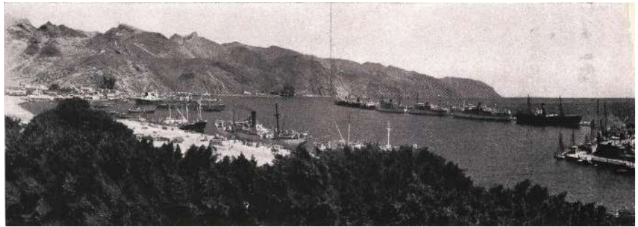
Figura 2.1: Puerto de Santa Cruz de Tenerife, 1953. Fuente: Revista Nacional de Arquitectura nº 140-141
