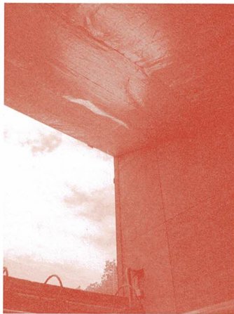
F2—Quisco de las Flores. Fachada sur y oeste, fachada norte y este, ventanal interior, estructura y acabado del techo.
