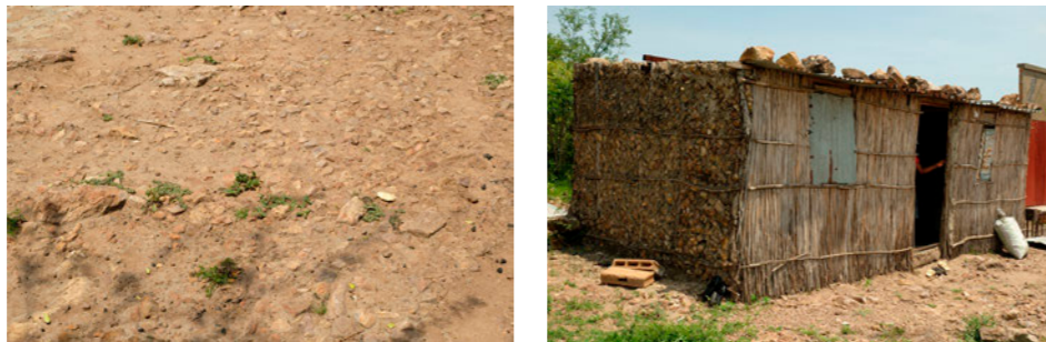
[Fig. 32 y 33] Terreno de viviendas clasificadas en el grupo 2. Elaboración propia.
