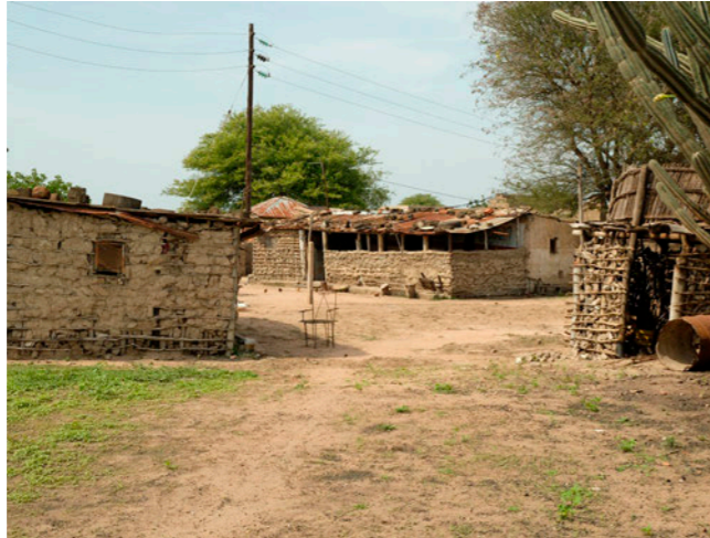
[Fig. 12] Vivienda localizada en un suelo de arena arcillosa aluvial en el distrito de Boane. Elaboración propia.
