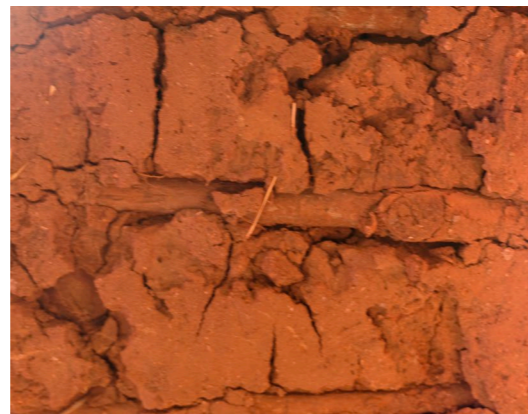
[Fig. 38 y 39] Relleno y revoco interior de barro en el entramado del cerramiento de pau-a-pique del dormitorio de la vivienda IM-07. Elaboración propia.
