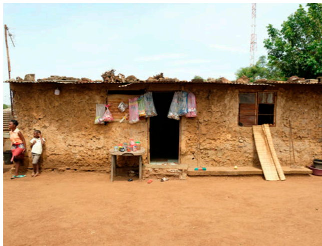
[Fig. 13] Vivienda localizada sobre un suelo basáltico en el distrito de Boane. Elaboración propia.
