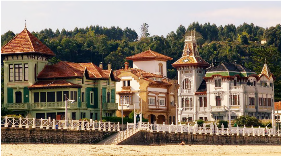
Fig 6. Fotografía realizada desde la playa de tres casas de indianos en Ribadesella. Fuente: Hotel El Carmen, Ribadesella
