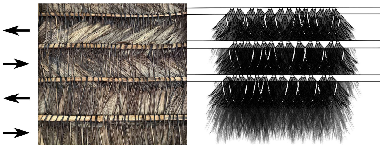
Vista desde el interior.
