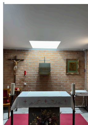
Figura 136. Espacio reserva Eucarística estado actual.
