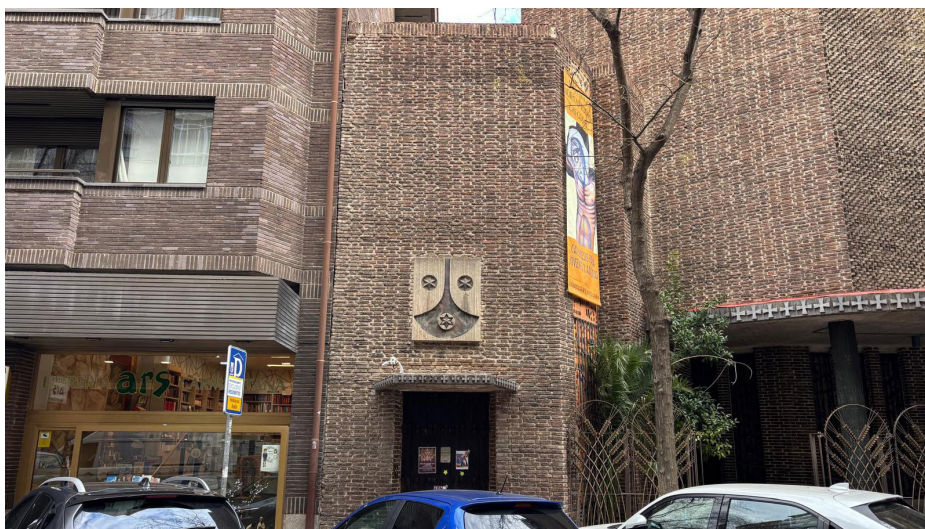
Figura 20. Medianera entre templo y edificio auxiliar de espacios parroquiales.
