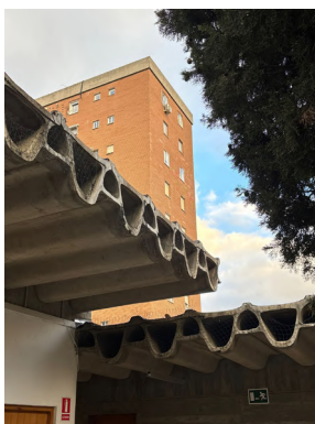
Figura 71. Detalle vigas hueso
