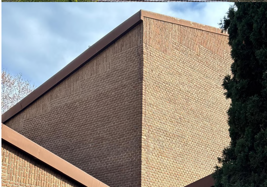
Figura 127. Detalle de la fachada
