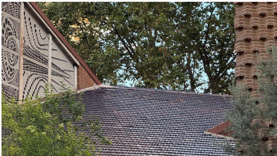
Figura 126. Detalle de la cubierta
