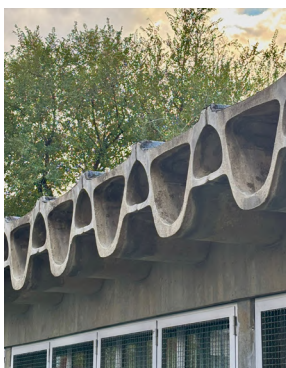
Figura 72. Detalle vigas hueso
