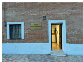
Figura 40. Entrada edificio parroquial
