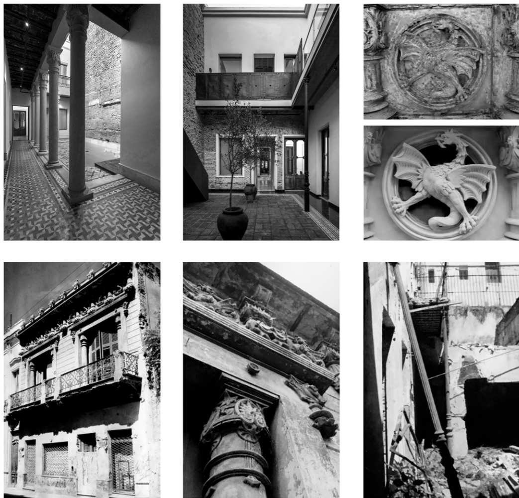
Fig 16. Imágenes del proceso de reconstrucción de la Casa de los Dragones 2010
