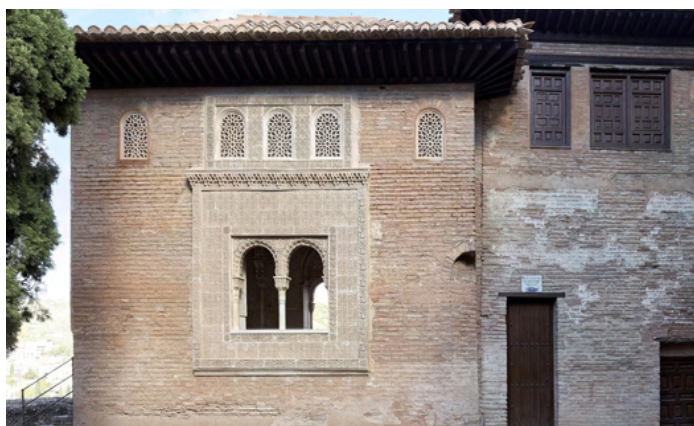
Figura 47: Fachada lateral suroeste del oratorio y la Casa de Astasio de Bracamonte tras la restauración de Federico Wulff Barreiro en 2017. Fuente: Ártico (s.f.).
