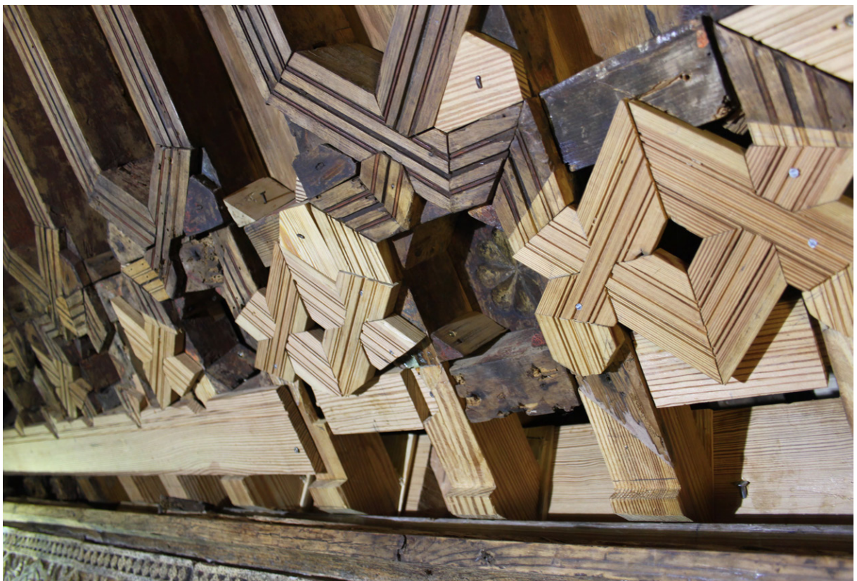
Figura 83: Piezas nuevas de la cubierta interna del oratorio. Fuente: Ártico (s.f.).
