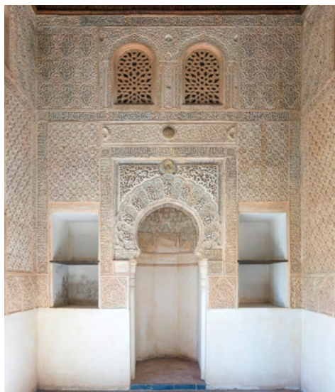
Figura 49: Vista interior de la entrada al Oratorio del Partal tras la restauración de Federico Wulff Barreiro. Fuente: W+G Arquitectos (2017).
