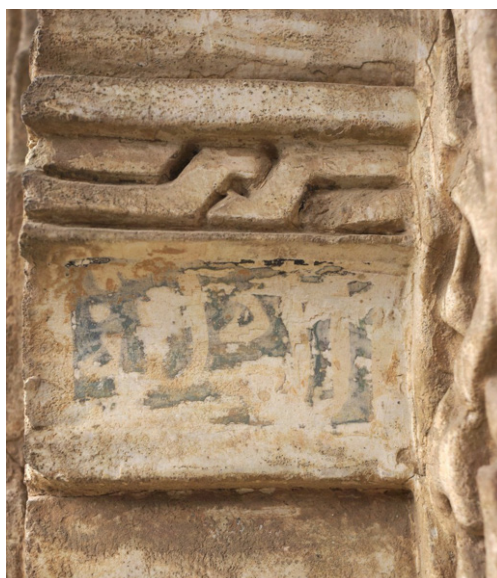
Figura 75: Estado previo a la intervención de las yeserías.
