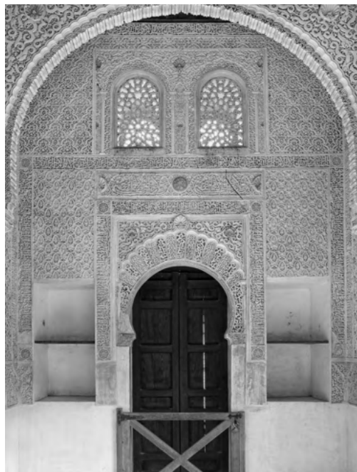
Figura 37: Vista interior de la entrada al Oratorio del Partal tras la restauración de Leopoldo Torres Balbás.
