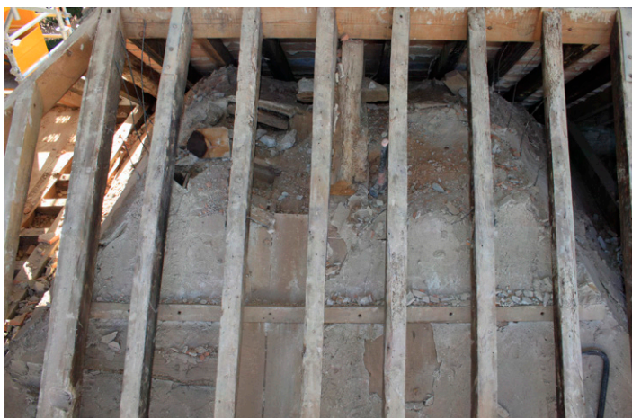
Figura 66: Estado previo a la intervención de la cubierta exterior.
