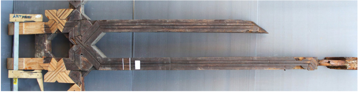
Figura 81: Par tratado de la cubierta interna del oratorio. Fuente: Ártico (s.f.).
