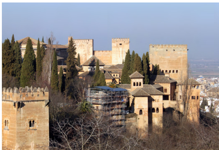
Figura 58: Conjunto de la Alhambra. Andamiaje del Oratorio del Partal para la última intervención.
