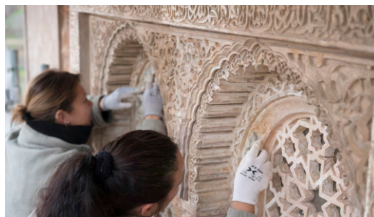
Figura 94: Intervención de las yeserías del oratorio.
