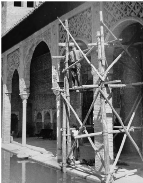
Figura 7: Sustitución de pilares de ladrillo por columnas de mármol. Fuente: Anónimo (1965).
