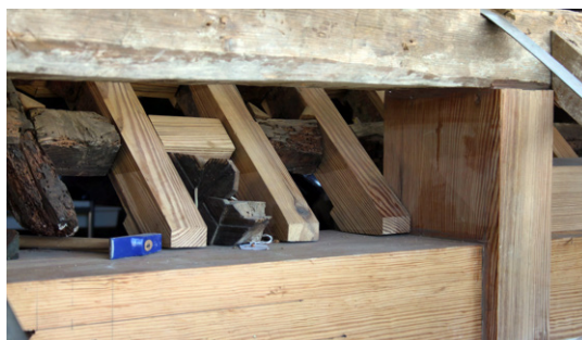
Figura 88: Estado final de la zona inferior de la cubierta tratada.
