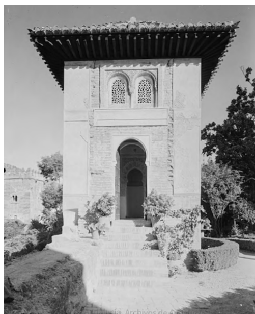
Figura 34: Fachada principal de acceso al Oratorio del Partal tras la restauración de Leopoldo Torres Balbás en 1930.
