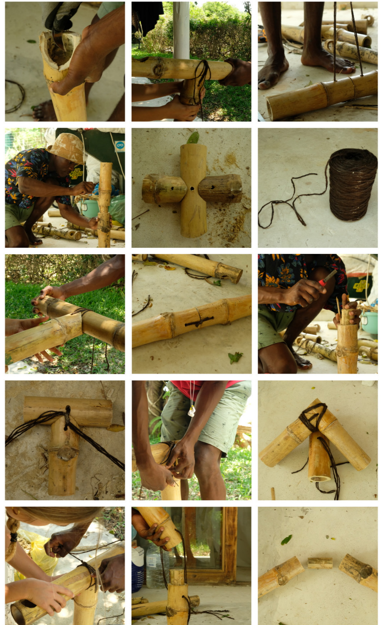
Fig 21. Proceso de elaboración de uniones de bambú. Elaboración propia.
