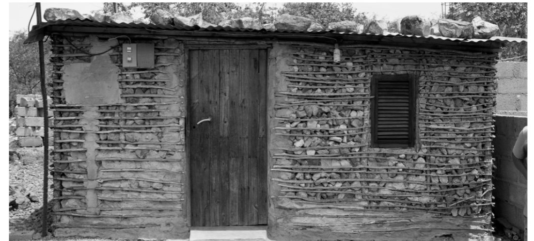
Fig 6. Vivienda tradicional de autoconstrucción. Elaboración propia
