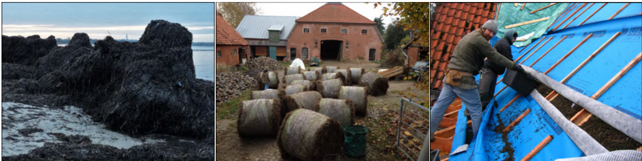
Fig 43. Fuente: WEB seegrashandel. Imágenes de procesos de recogida, almacenamiento y puesta en obra.
