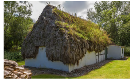
Fig 29. Fuente: magnusmund. Imagen de una de las pocas casas con cubierta algal que quedan en pie de la isla de Læsø
