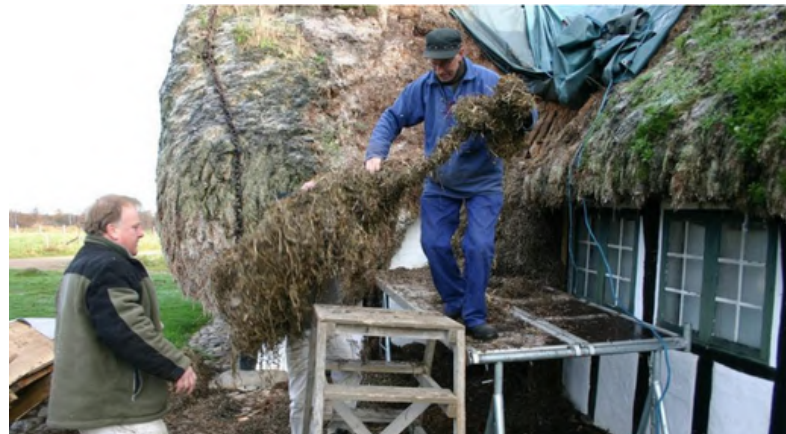
Fig 31. Fuente: magnusmund. Imagen de proceso constructivo de la cubierta.
