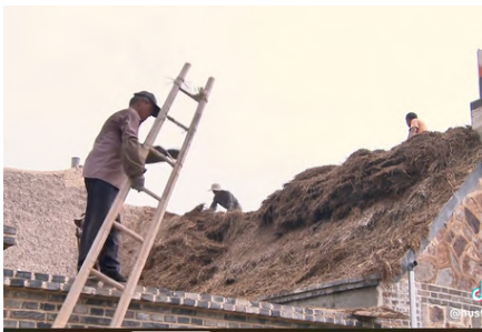
Fig 36. Fuente: web Tiktok. Imagen extraída de video explicativo de la construcción de las cubiertas de Jiaodong.
