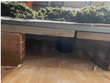
Fig 122. Fuente: Elaboración propia. Fotografía de fuente de calor junto a sistema de forjado sanitario.
