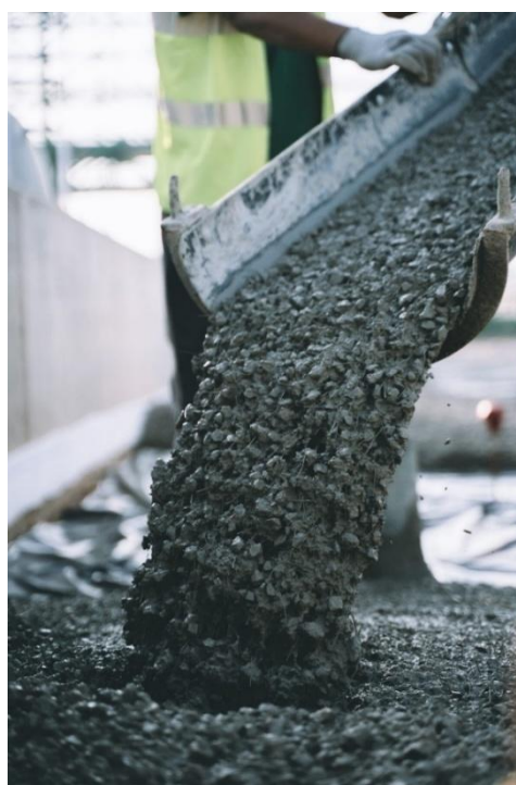
Fig 3.11. Vertido de hormigón
