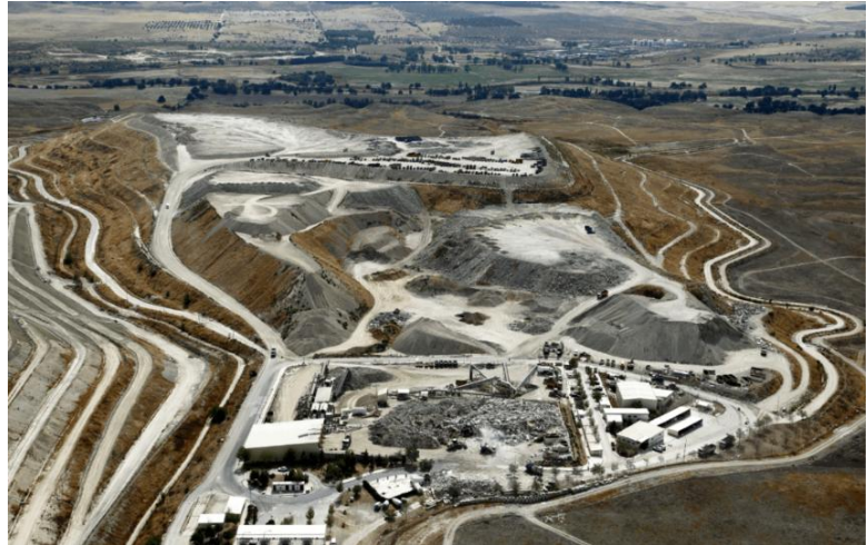
Fig 3.26. Planta de RCD y vertedero
