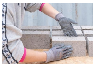
Fig 4.21. Fraguado y curado al aire.
