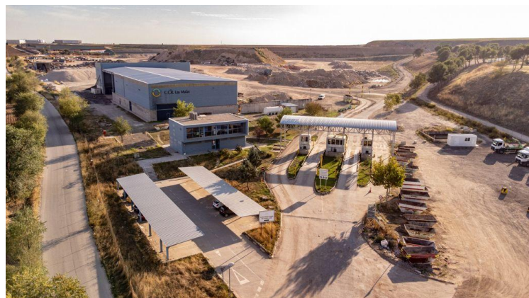
Fig 3.27. Planta de RCD y vertedero
