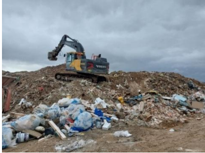
Fig 3.75. Excavadora manejando RCD sucios
