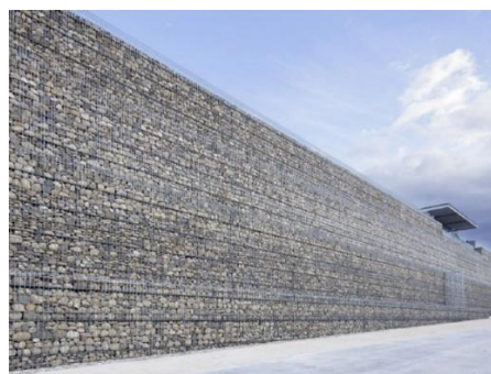
Fig 4.12. Muro de tierra armada
