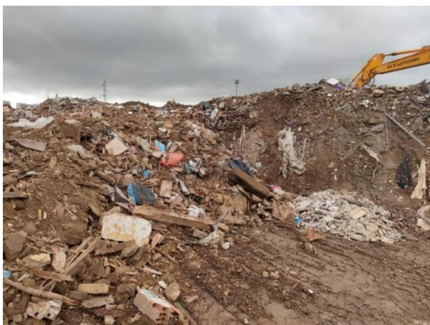
Fig 3.54. Excavadora-trituradora machacando escombros
