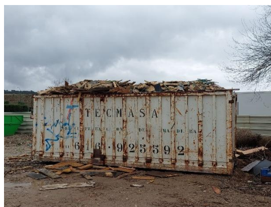
Fig 3.17. Escombros de madera en contenedor
