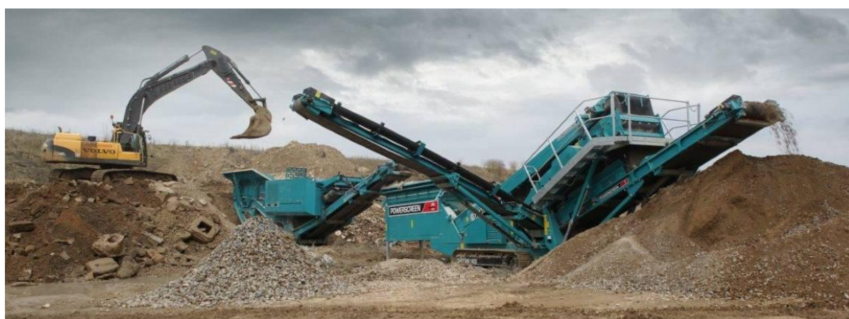
Fig 3.04. Maquinaria de separación y triaje de escombros
