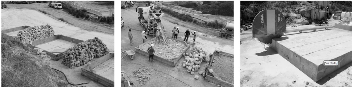
Fig 4.02. Fabricación bloques de marés reciclado
