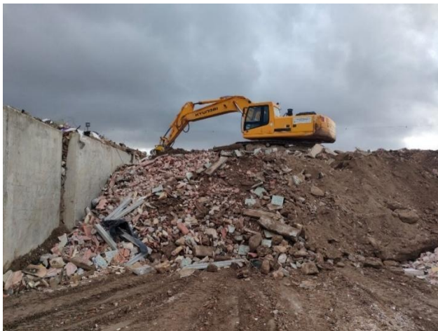
Fig 3.54. Excavadora-trituradora machacando escombros
