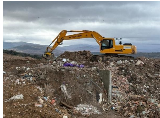
Fig 3.50. Excavadora manejando RCD
