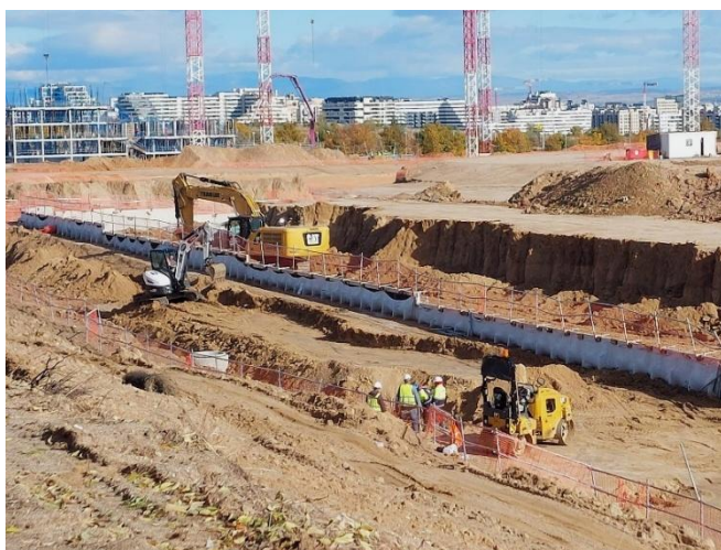
Fig 3.01. Operaciones de movimiento de tierras
