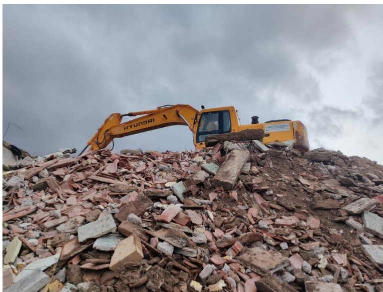
Fig 1.01. Escombros de obra con retroexcavadora
