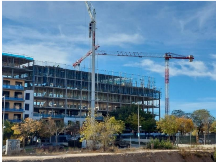
Fig 3.02. Construcción de edificio de viviendas
