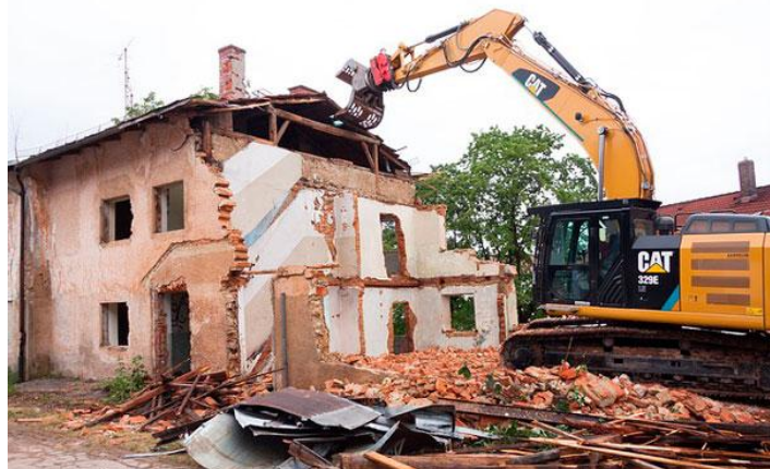
Fig 3.03. Obra de demolición
