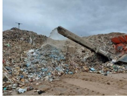
Fig 3.76. Trituradora moliendo RCD sucios
