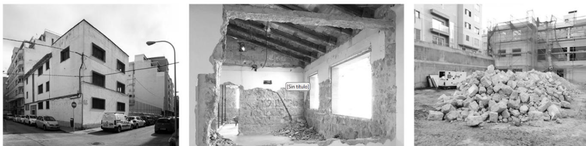
Fig 4.01. Demolición antigua escuela
