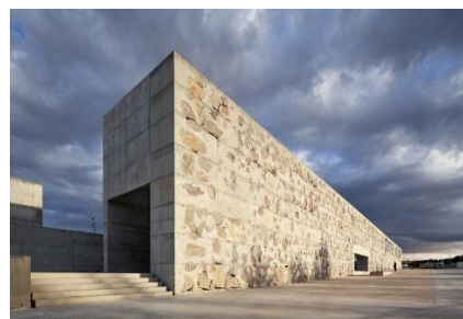
Fig 4.14. Muro de hormigón ciclópeo
