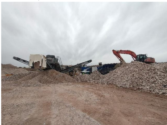
Fig 3.66. Trituradora y excavadora de RCD
