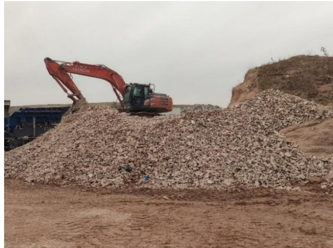
Fig 3.18. Residuos limpios de hormigón
