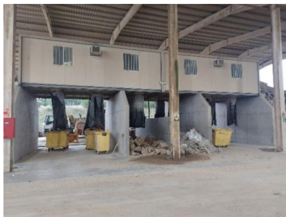
Fig 3.49. Cabina de triaje con contenedores para impropios
