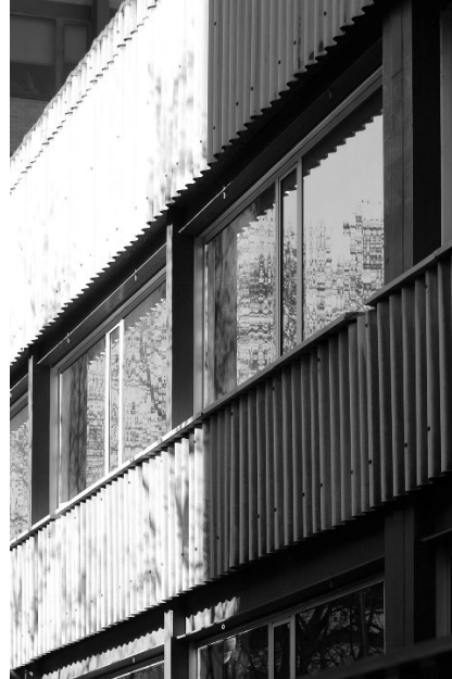
FIG. 19. Diario Arriba. Cerramiento nave de rotativas, 2020. Fotografía del autor.
