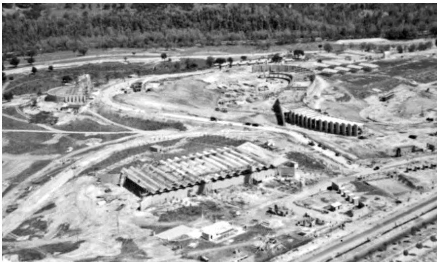
FIG. 5 Construcción del conjunto representativo de la II FIC: Acceso, Internacional, Agricultura e INI. CECAF, 1953.
