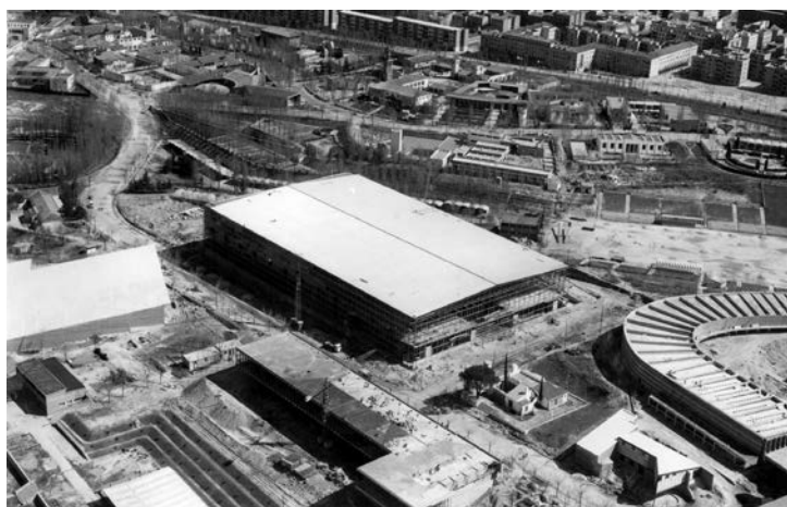
Fig. 1. Pabellones de Cristal y de la Pipa, al fondo los regionales, 1965. Fotografía, legado Cabrero, COAM.
