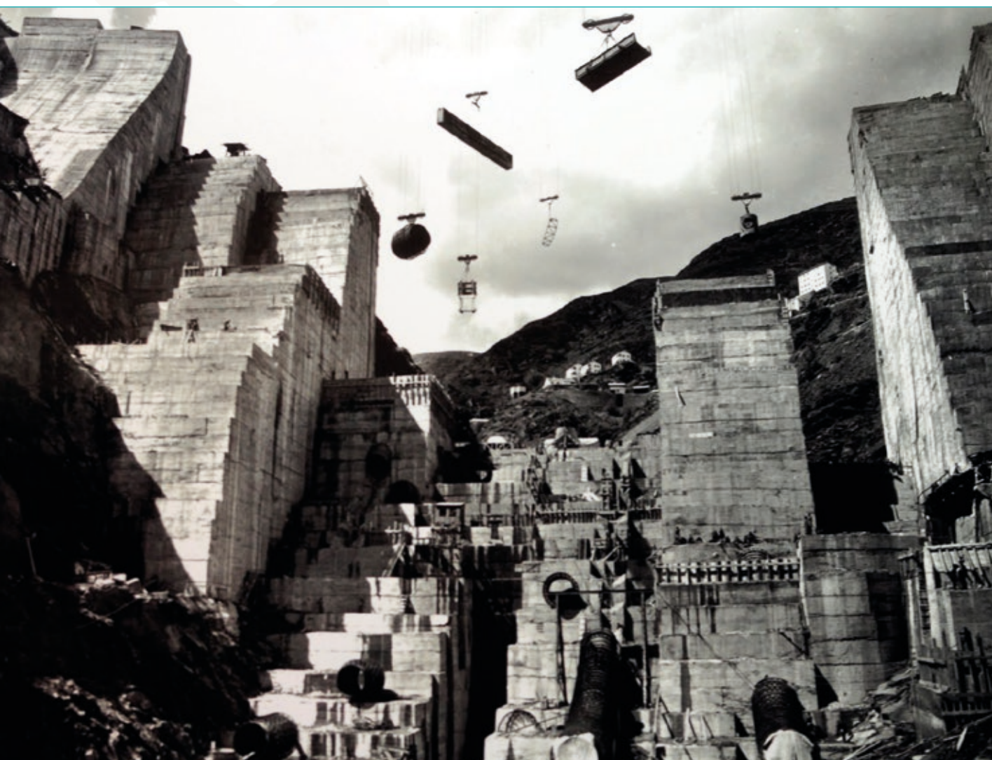
Vista de la presa de Salime aguas abajo. Juan Pando Barrero, c. 1953. Saltos del Navia, C.B.
