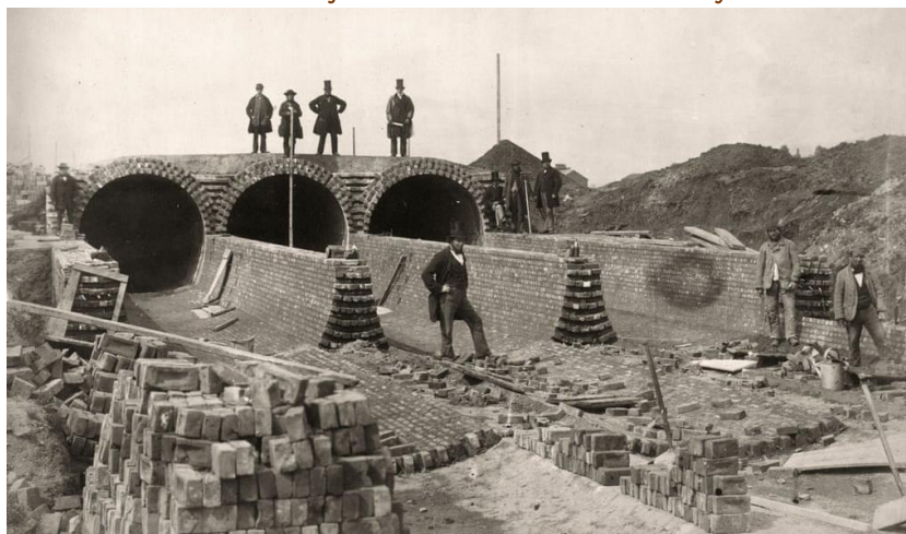
Figura 3. Joseph Bazalgette en el colector de desagüe del Norte de Londres en construcción bajo la estación de bombeo Abbey Mills
