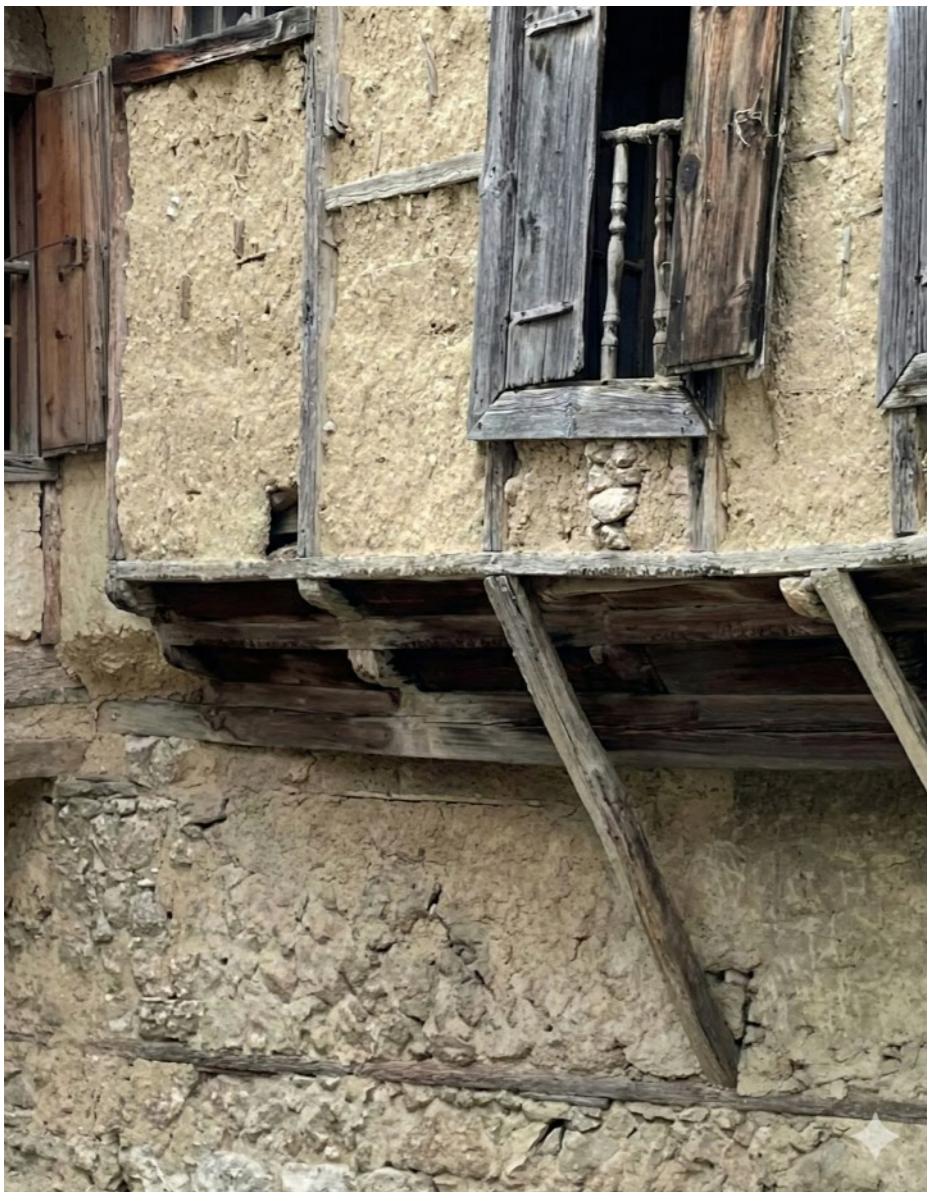
Fig 3.12. Balcón de la vivienda a analizar Fuente: (Saygi, 2024)
