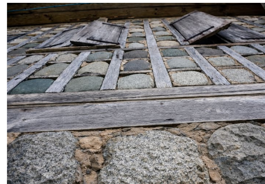
Fig 6.16. Detalle de las células de la fachada de la Casa Aydınoglu Fuente: (Güler, 2012)
