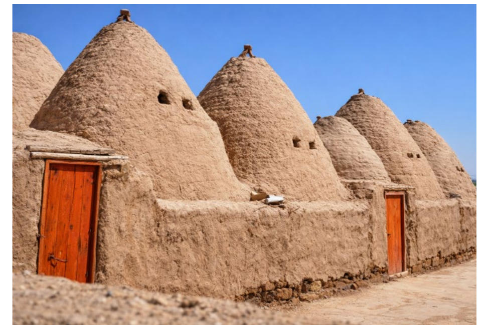
Fig 5.15. Vivienda con módulos de cúpula Fuente: (Kemal Yildirim, 2015)
