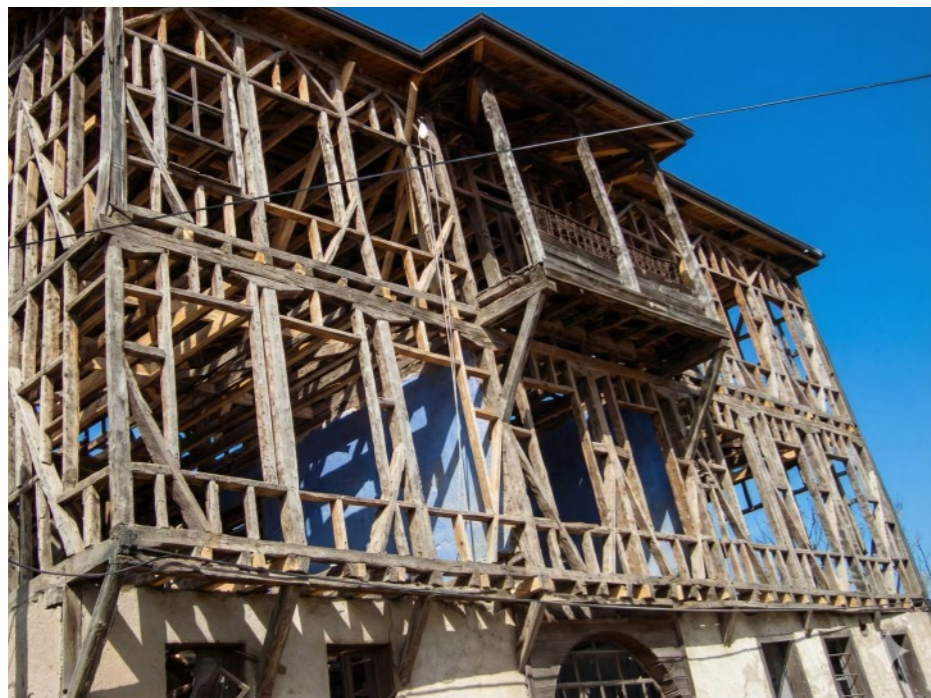
Fig 3.10. Estructura de madera de vivienda tradicional en Safranbolu Fuente: (Esat Güneş, 2014)
