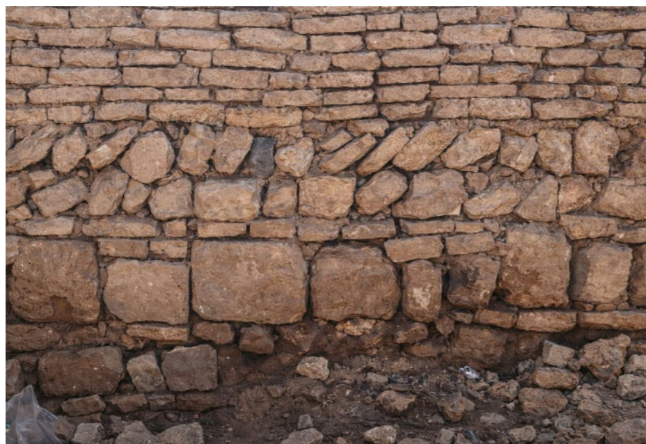
Fig 5.13. Detalle de muro de vivienda cúpula en Harran Fuente: (Kemal Yildirim, 2015)
