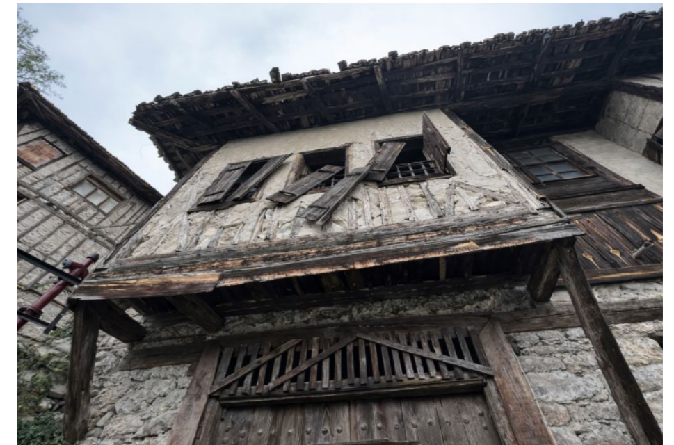
Fig 3.13. Balcón de la vivienda a analizar Fuente: (Saygi, 2024)
