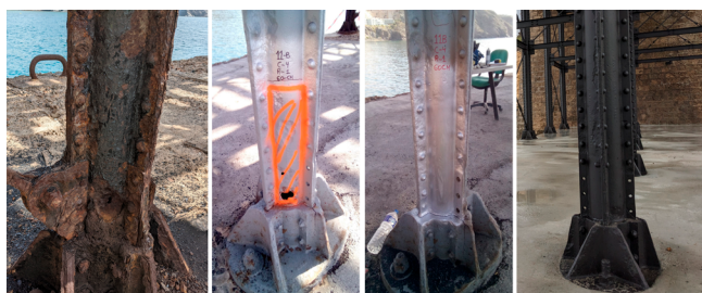
Figura 12. Imágenes del proceso de reparación de las columnas Félix del Embarcadero del Hornillo. Estado previo a la intervención; una vez retirada la brea y la suciedad y oxidado (se marca la zona de chapa a reemplazar); una vez reparada la sección metálica y, finalmente, una vez pintado
