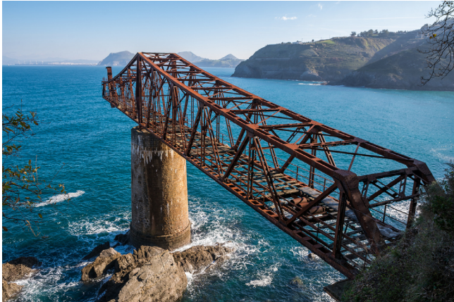
Figura 2. Vista del Cargadero de Dícido desde la costa
