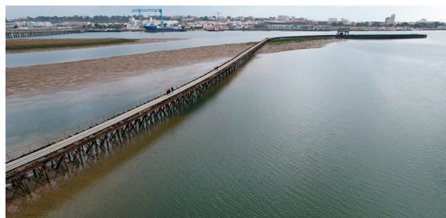
Figura 1. Vista aérea del Muelle de Tharsis al comienzo de las obras de reparación
