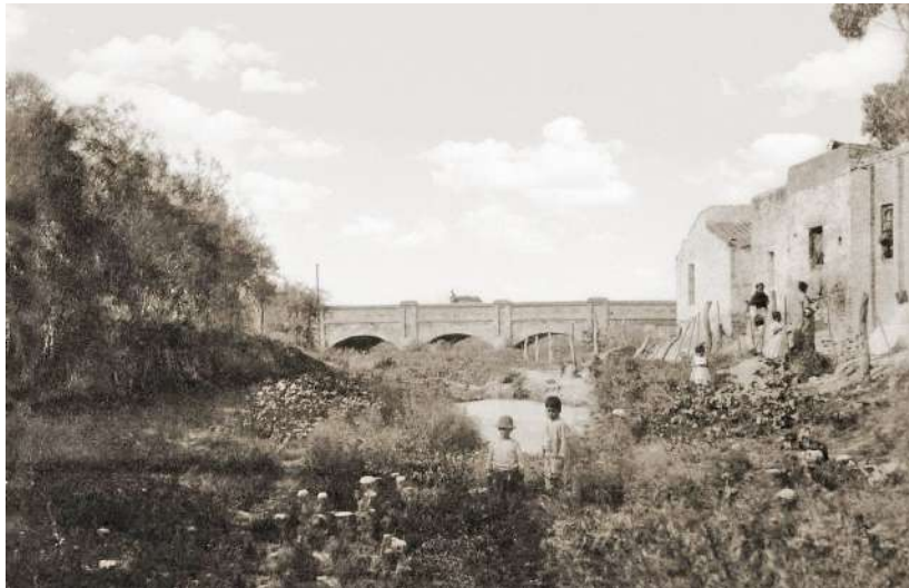
[55] Entubamiento del arroyo Maldonado. Arriba: Av. Juan B. Justo y el actual viaducto del ferrocarril San Martín. CABA, 2025. Abajo: Arroyo Maldonado y el antiguo viaducto. Fotografía de Samuel Rimathe. Buenos Aires, 1890.
