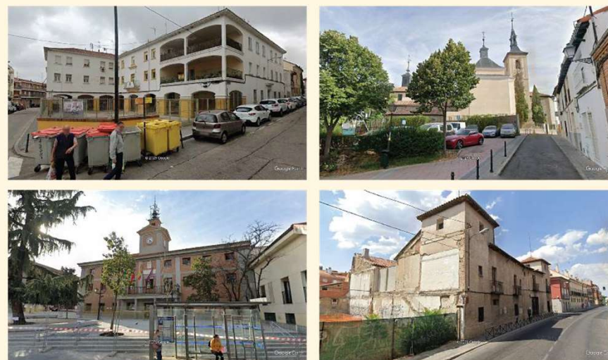
Figura 9.2. Colonia de San Vicente, Iglesia de San Miguel Arcangel, Edificio del exayuntamiento y Casa Grande. Imágenes de Google Streetview.
