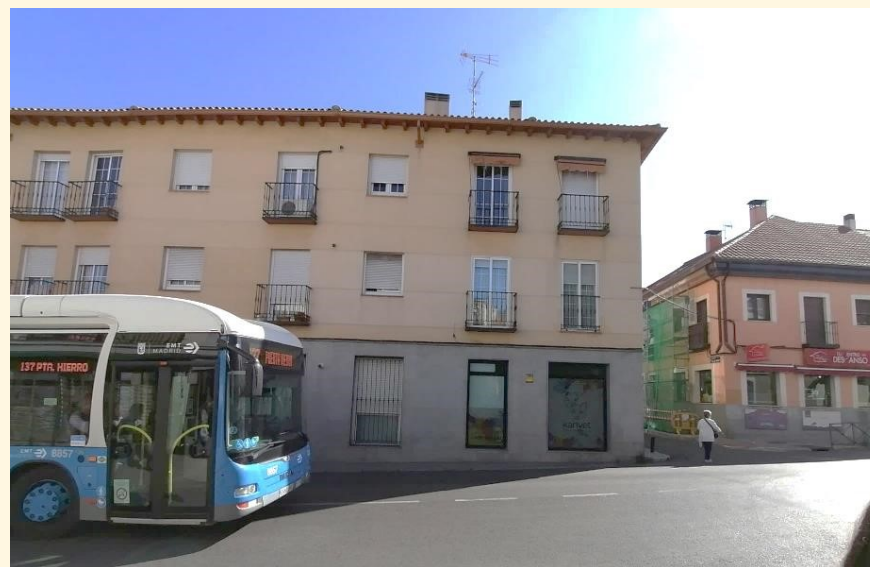
Figura 1.1. Tramo de la Calle Nuestra Señora de Valverde donde la acera prácticamente desaparece.
