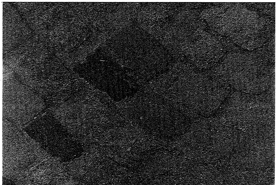
Intercalación de adoquines fabricados con variedad de rocas ígneas: volcánicas e intrusivas.
