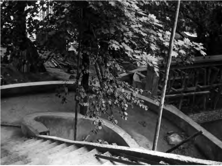
Fig. 6. Construcción de la rampa de acceso a la segunda planta.
