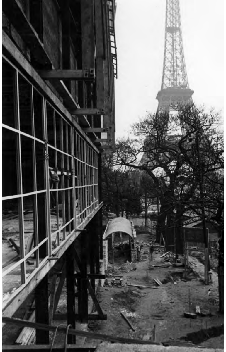
Fig 4. Vista de la construcción del Pabellón.
