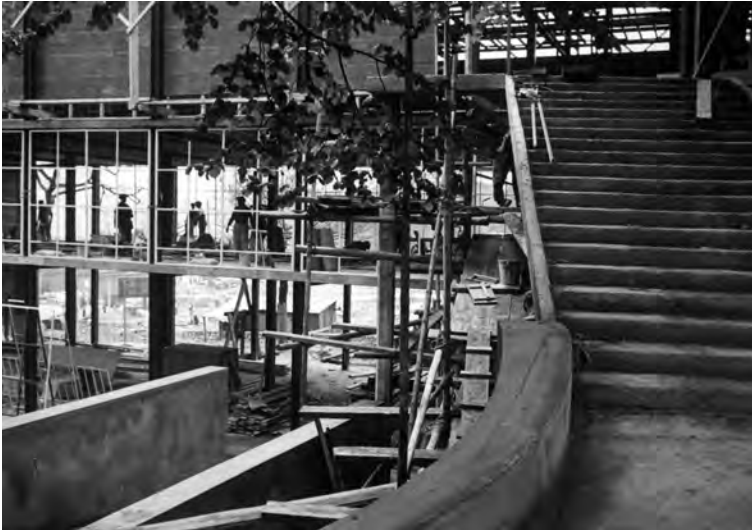
Fig. 5. Vista de la construcción del Pabellón.
