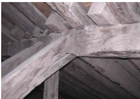
Fig. 3.4.A/2. El embarbillado de este jabalcón, y la poca resistencia de la madera a su hienda, reducen significativamente la funcionalidad de la pieza y ponen en duda su eficacia
