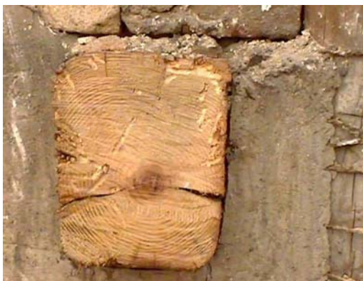
Fig. 1.3/3. Las fendas de una viga llegan, en este caso, hasta el corazón de la pieza, y casi la parten en dos. La viga funciona, en esta sección, como una doble T con aproximadamente los 2/3 superiores como cabeza comprimida, y el tercio inferior de tracción, y el corazón absorbiendo el rasante correspondiente, pero esto va cambiando en diferentes secciones según sea la posición y profundidad de las fendas
