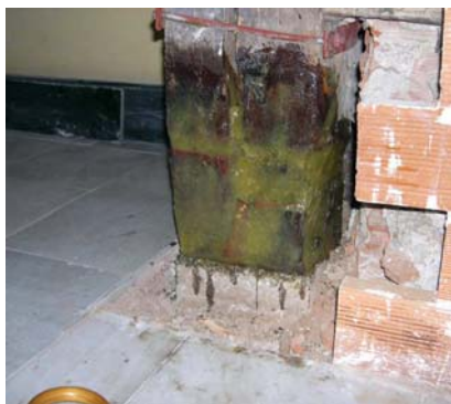
Fig. 5.5.D/1. Calzado de un pie derecho con pasta de resina epoxi anclada y armada con varillas de fibra de vidrio. Las fendas superiores están contenidas con bridas de acero
