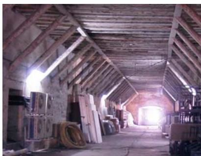
Fig. 5.5.C/2. Apeo permanente de un forjado con dos líneas de jabalcones en los cuartos de la luz (Clerecía de Salamanca)
