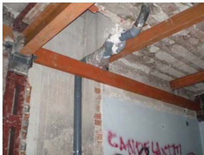
Fig. 5.5.C/1. Apeo permanente de un forjado mediante dos planos de perfiles de acero laminado. El primero recoge la carga del forjado en los cuartos de su luz, y el segundo la del primero, para llevarla a los pilares
