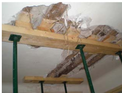
Fig. 5.1.A/2. Apeo de viguetas con dos líneas cercanas a cada uno de sus dos apoyos
