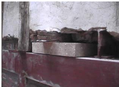
Fig. 5.6.A/1. Sustitución de una carrera con perfiles de acero laminado. El muro y el pie derecho superiores están calzados provisionalmente con cuñas y tacos de madera
