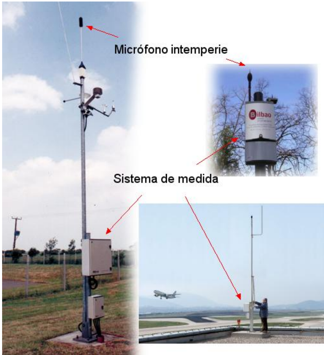
Figura 3. Terminales de monitorado de ruido
