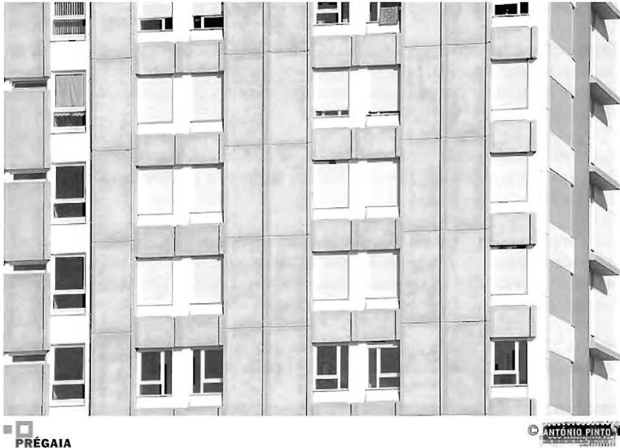
Figura 14: Sistema de paneles prefabricados en un edificio de cooperativa. Detalle.
