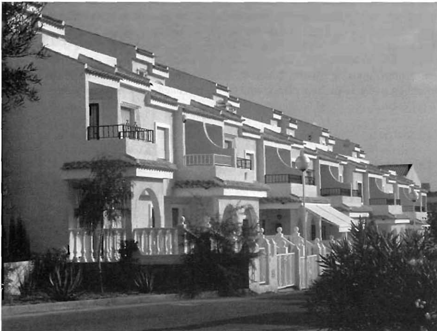
Figura 12: Sistema de construcción con paneles portantes. Realización terminada.
