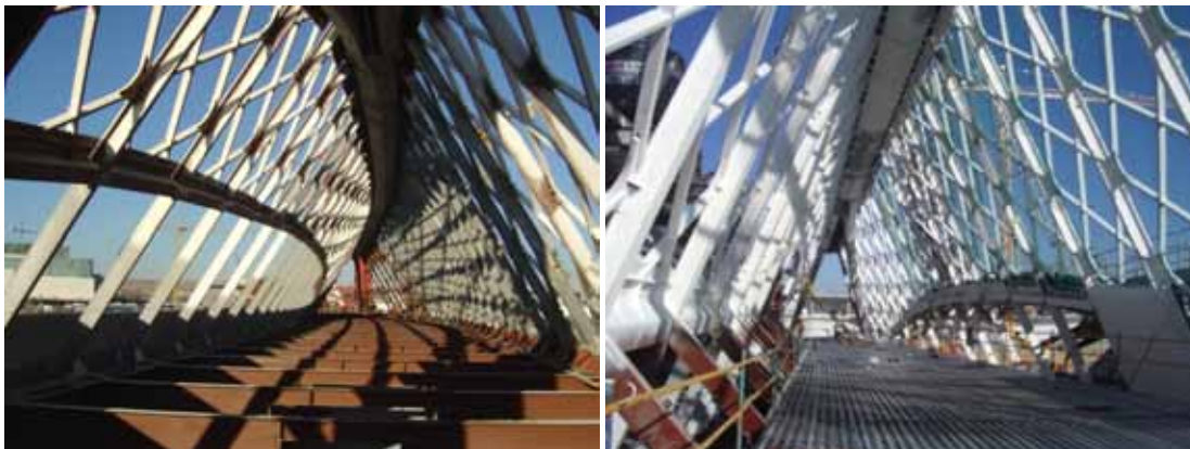
Fotos de la obra en Construcción
