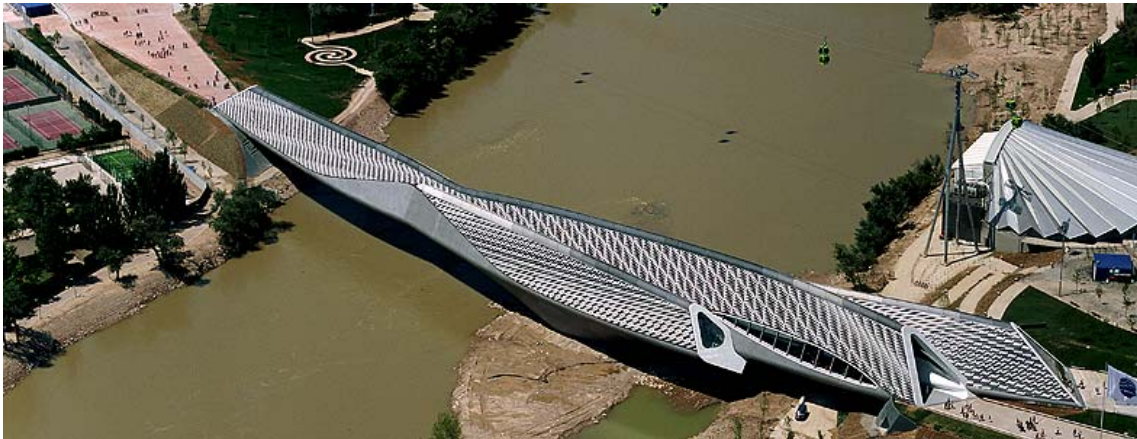
Vista aérea de la obra terminada
